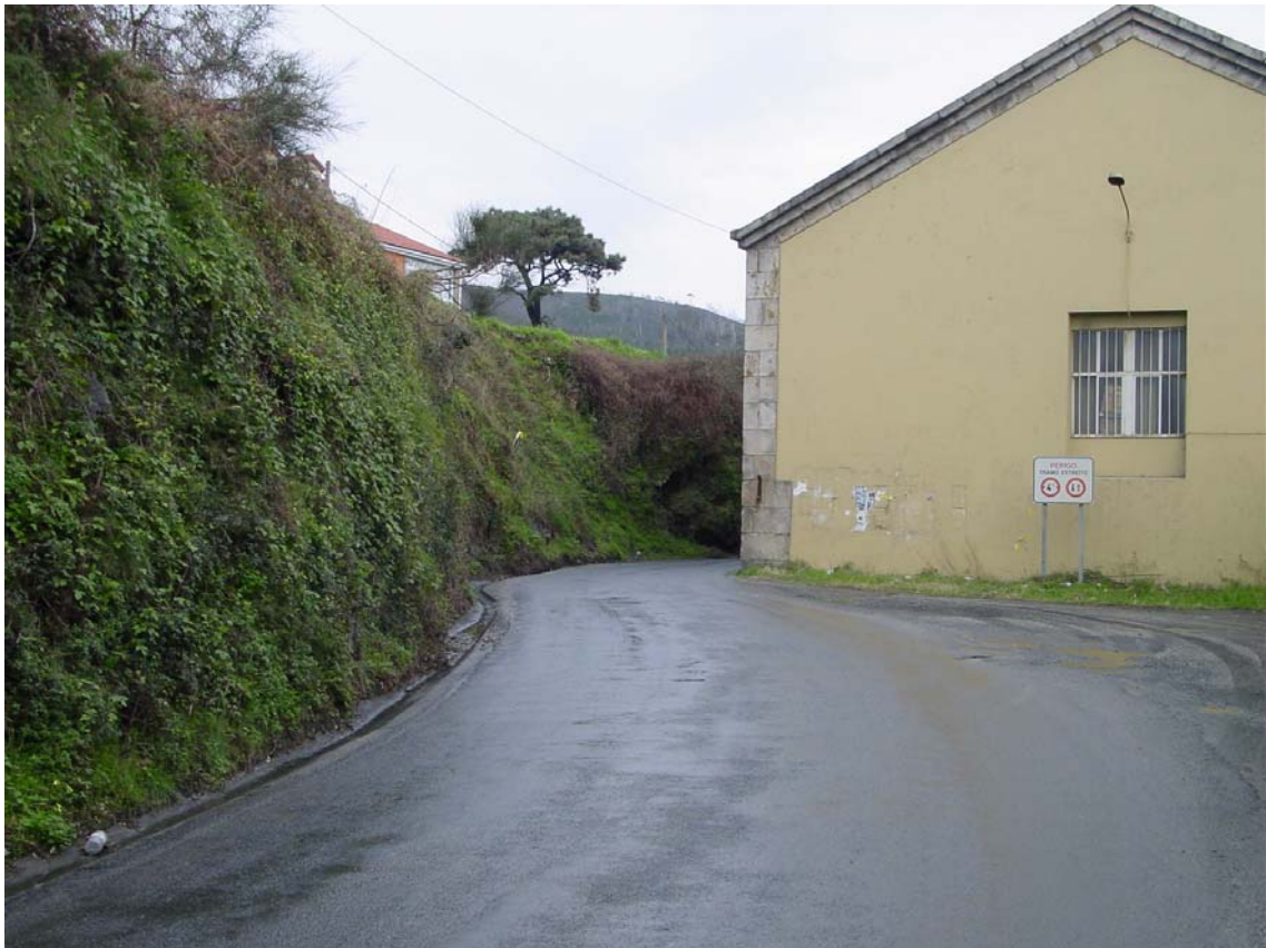
FOTO 17: ZONA DE AMPLIACIÓN DEL ACCESO.
