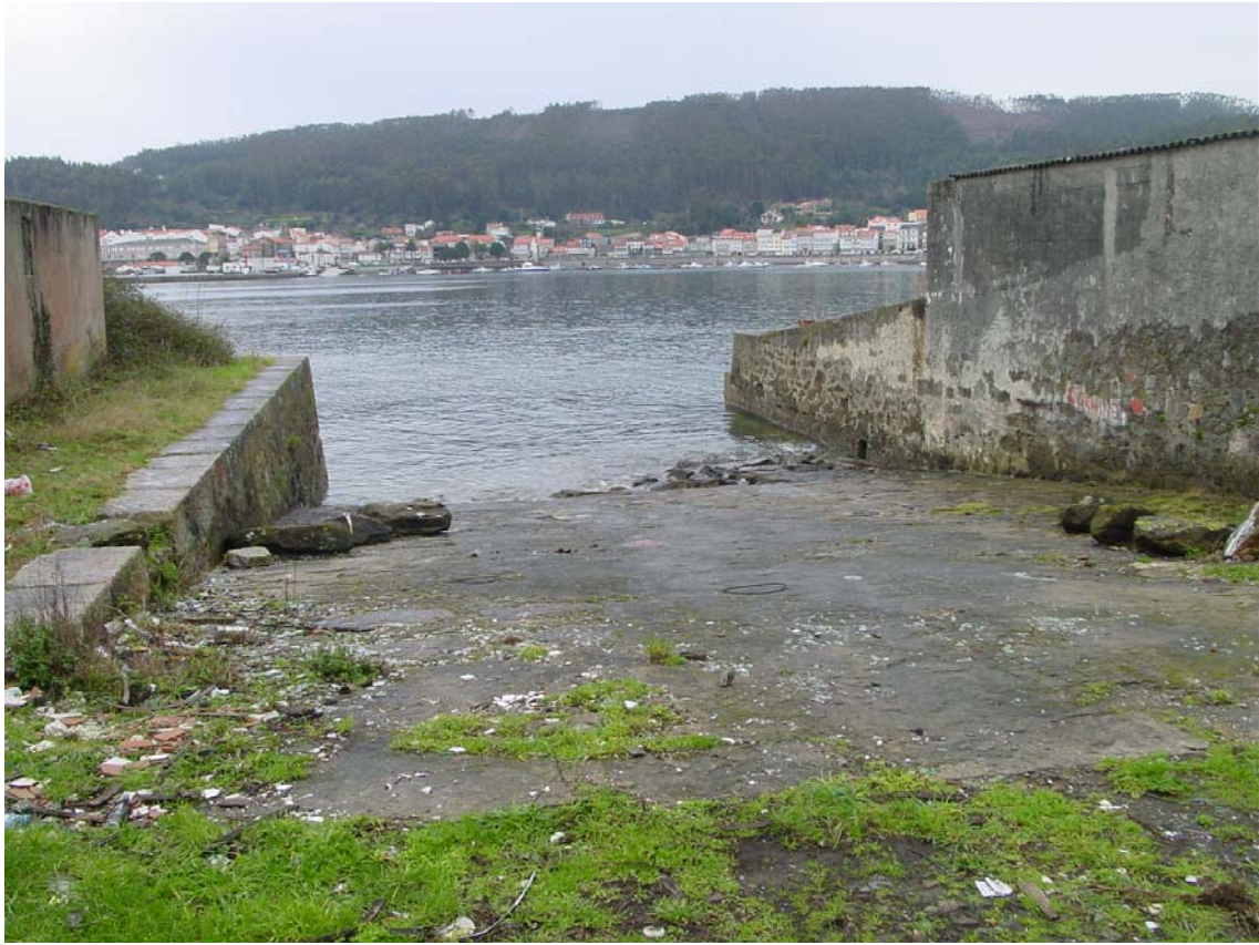
FOTO 8: RAMPA EN RUINAS ENTRE DEPURADORA Y ASTILLEROS SICAR.
