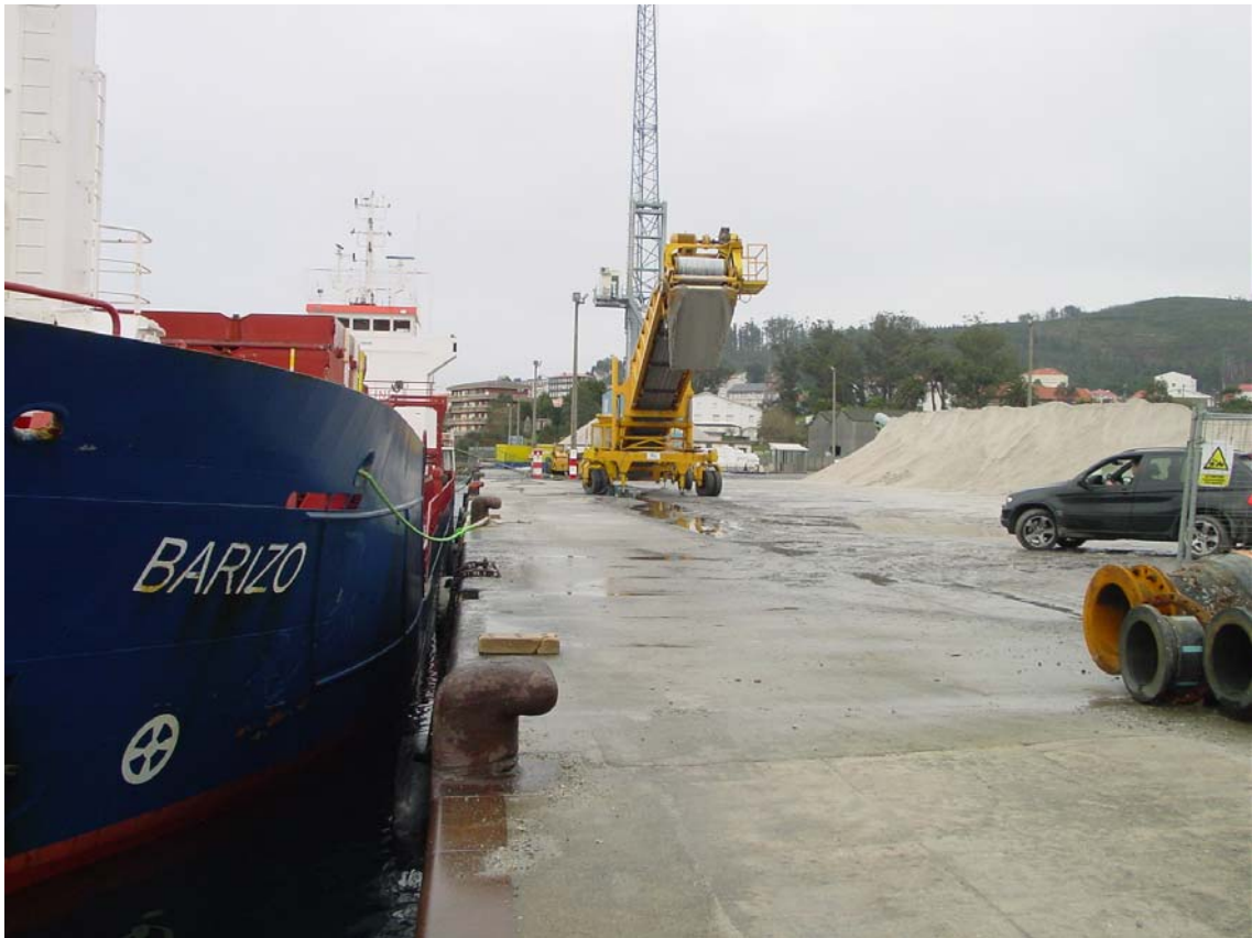
FOTO 12: VISTA DE DETALLE DEL CANTIL DEL MUELLE COMERCIAL.
