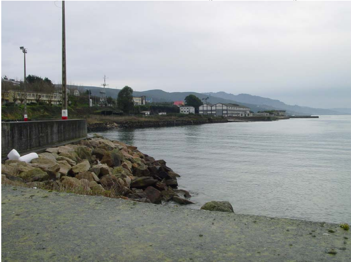
FOTO 3: VISTA GENERAL DESDE EL DIQUE PESQUERO CON RAMPAS Y DEPURADORA.
