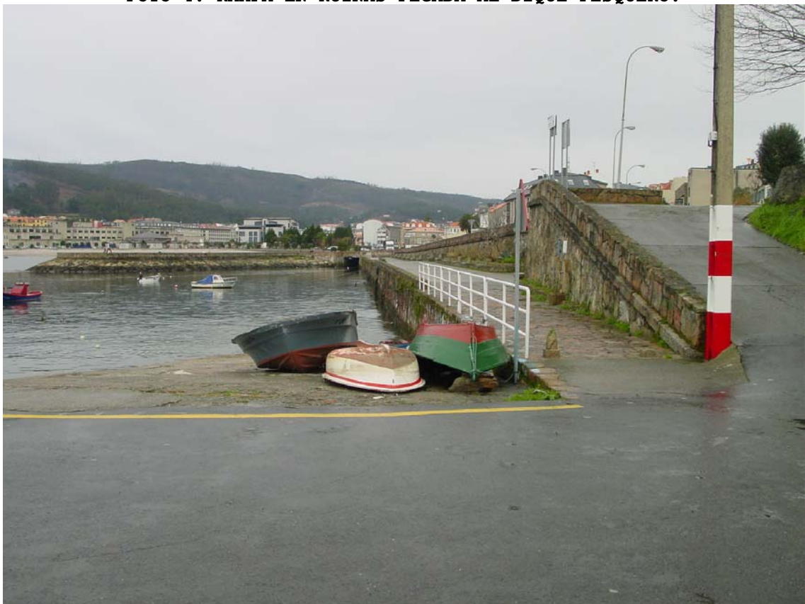
FOTO 5: RAMPA EN EL INTERIOR DE LA ZONA DE FONDEO Y PASEO MARÍTIMO.
