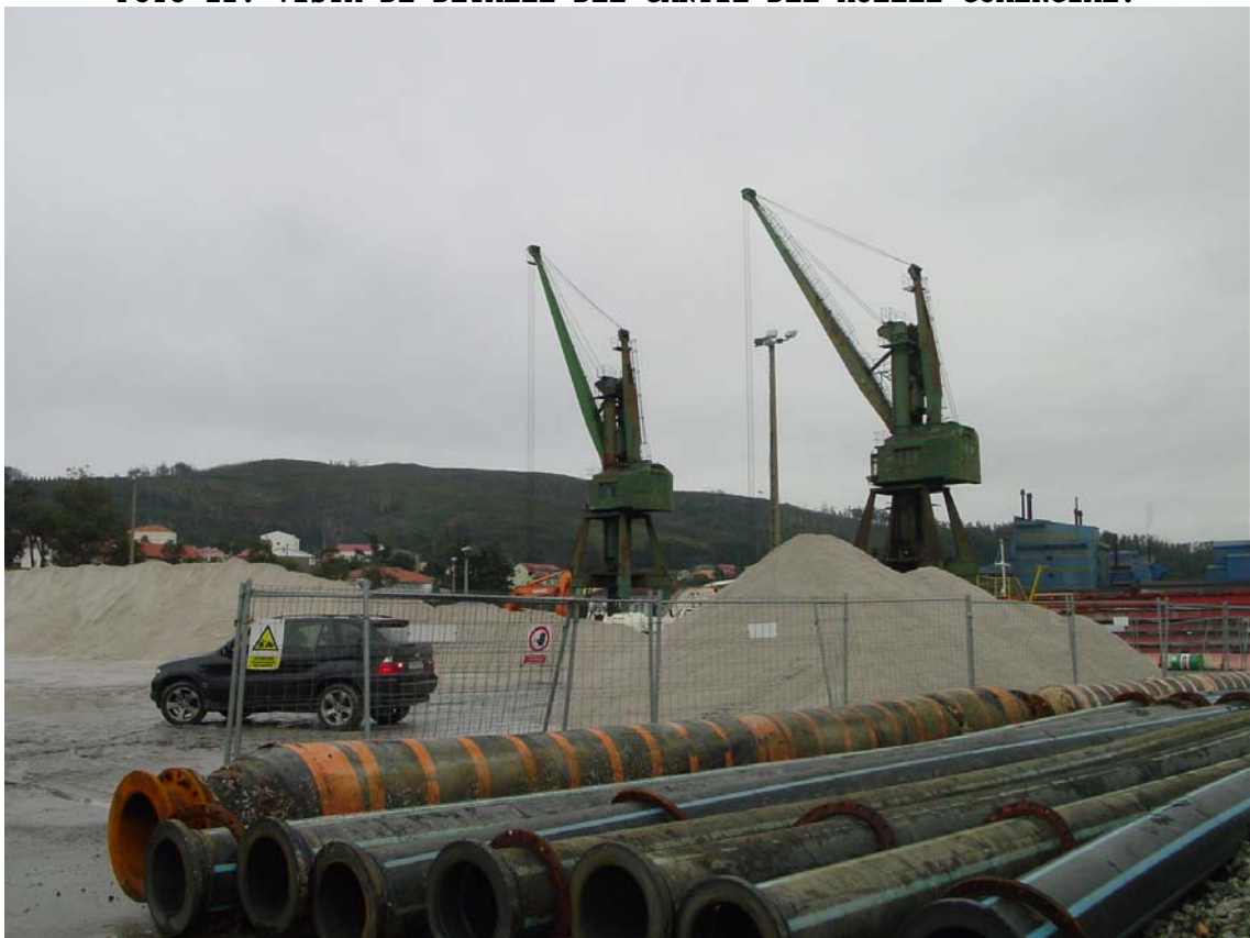
FOTO 13: GRÚAS EN DESUSO.
