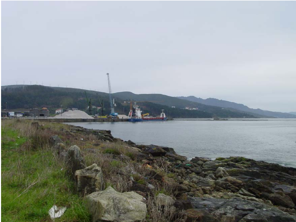
FOTO 11: VISTA GENERAL DEL MUELLE COMERCIAL Y OBRAS DE AMPLIACIÓN.
