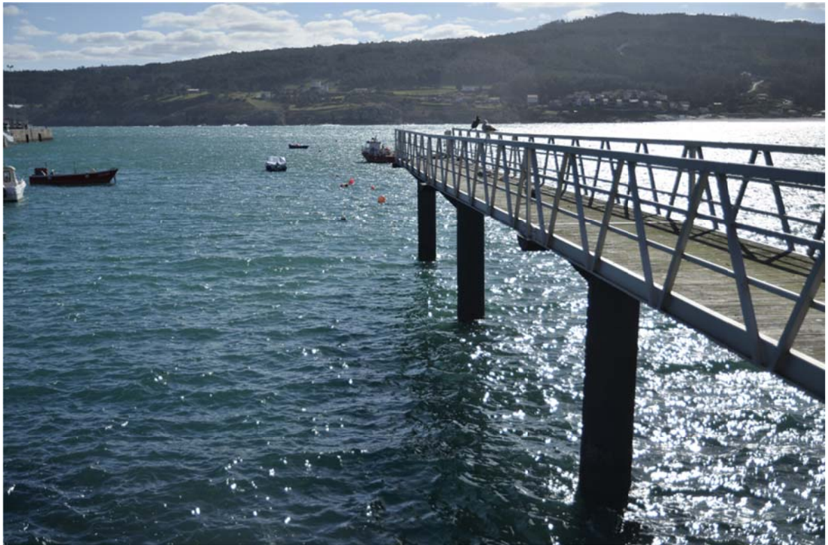
Vista de la pasarela existente
