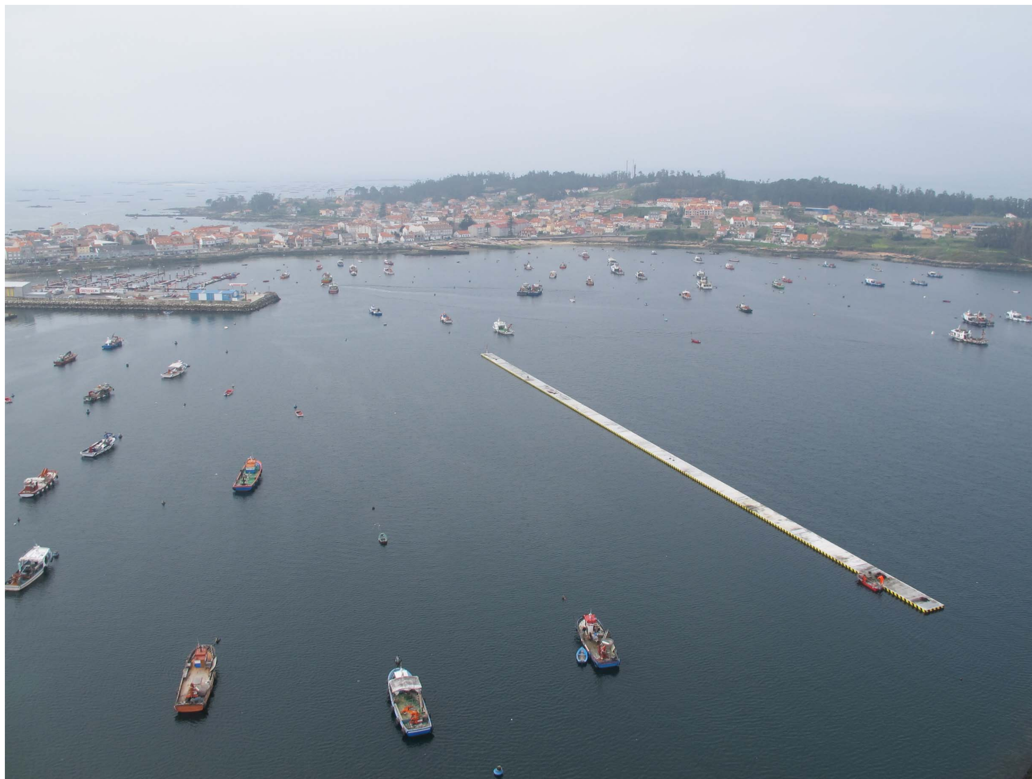
Foto 11. Imagen del rompeolas flotante ya instalado
