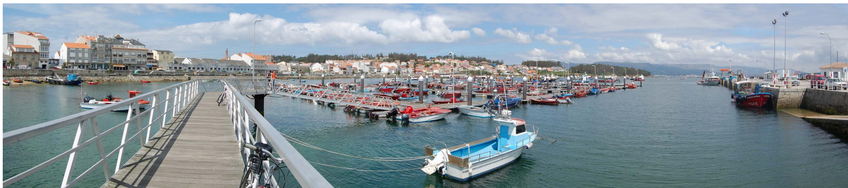
Foto 8. Vista de la dársena interior desde el acceso a pantalanes.
