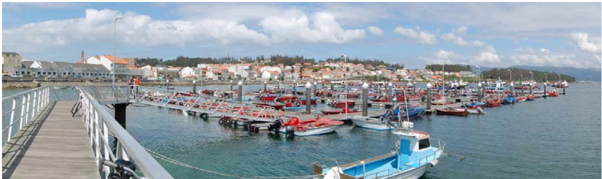
Figura 3. Instalaciones para embarcaciones menores en el puerto de O Xufre
