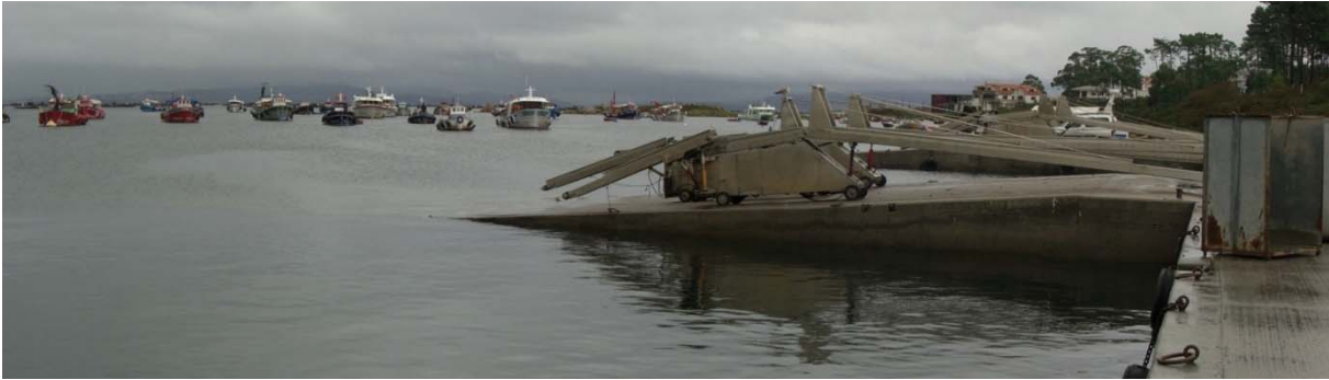
Figura 7. Vista de una de las rampas de descarga de la dársena intermedia.
