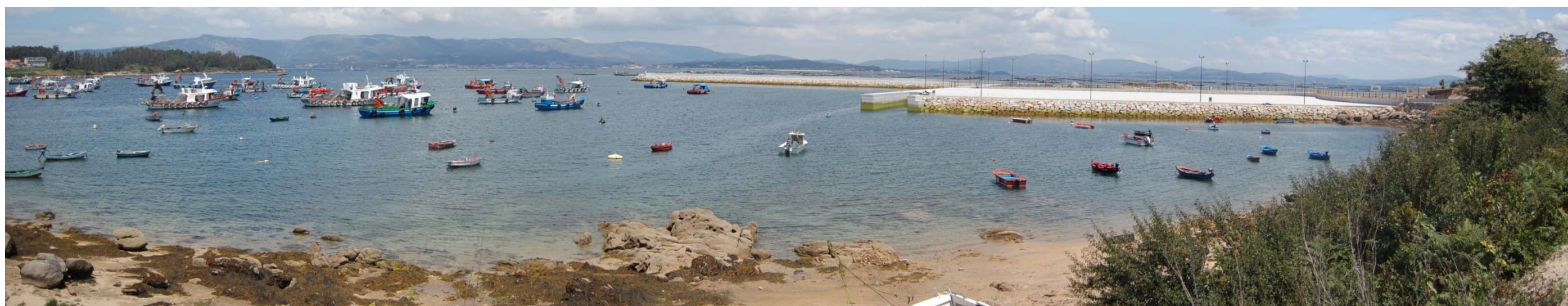
Foto 10. Panorámica de la dársena exterior desde la carretera de acceso al puerto.
