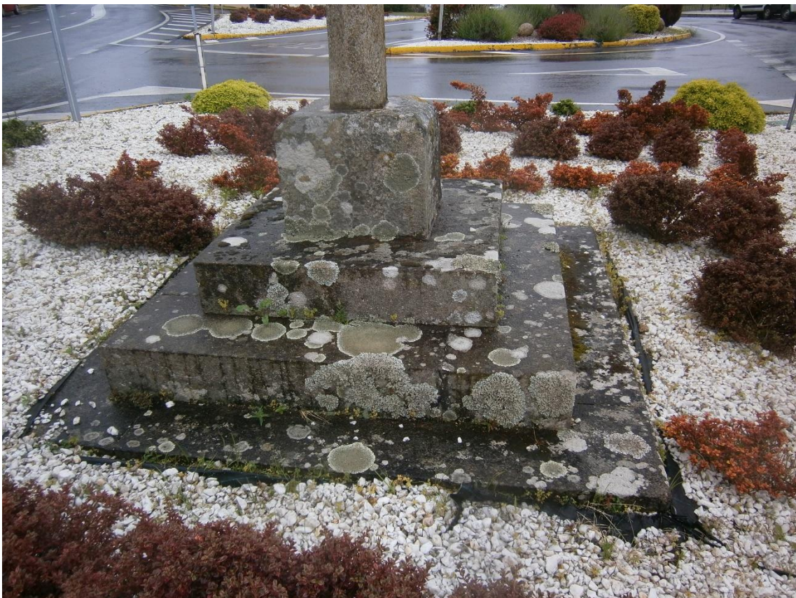
Imagen de detalle de la base del cruceiro y escalinata
