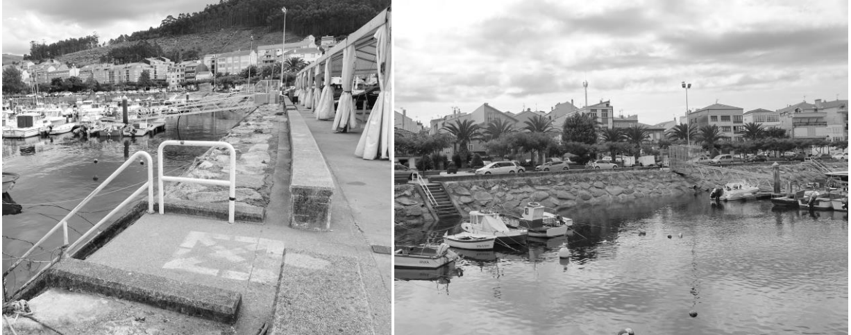
Escaleras y rampas de bajada a los pantalanes y tratamiento actual de la escollera
