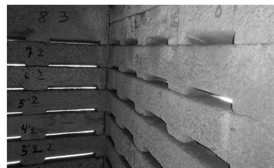
NUMERACIÓN PIEDRA A PIEDRA EXISTENTE PARA NUEVO TRASLADO
