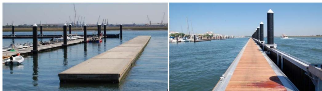
Figura 1. Dique flotante (izquierda) y pantalla flotante (derecha) en Punta Umbría
