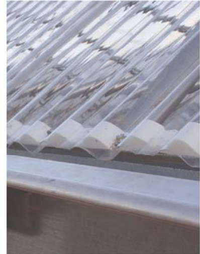
Sujeción policarbonato semionda
