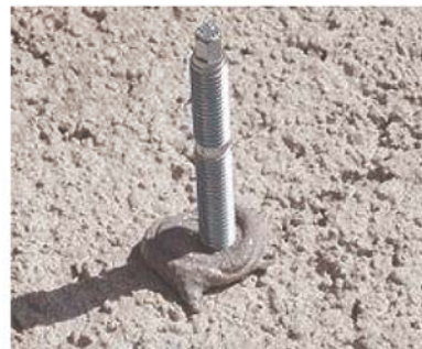
Varilla roscada sujeta con resina epoxi
