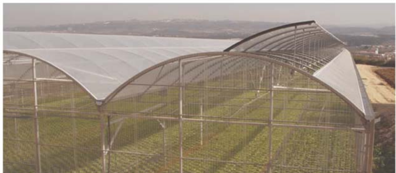
Naves de 10m con ventilación cenital a 1/4
