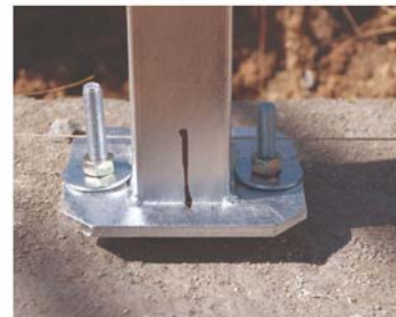
Pilar con placa de anclaje
