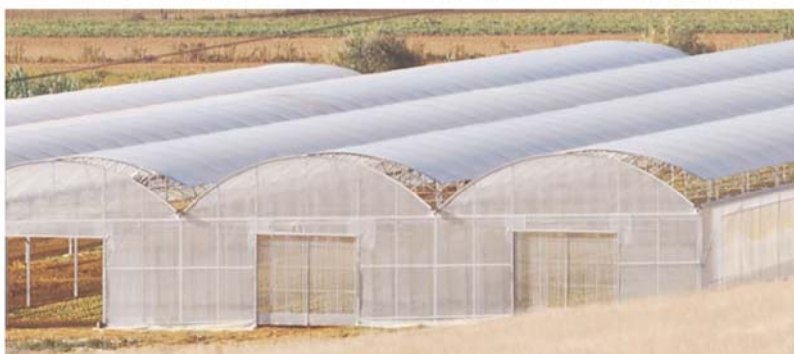
Naves de 10m con ventilación cenital a 1/2
