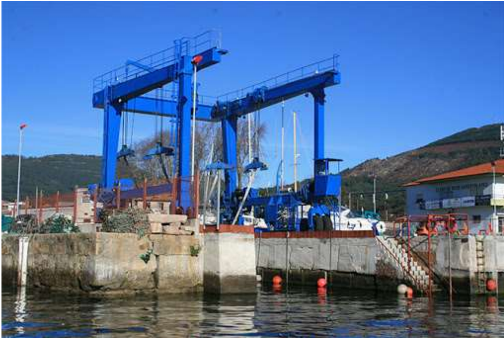
Imagen 11. Foso travelift en el puerto de Meira
