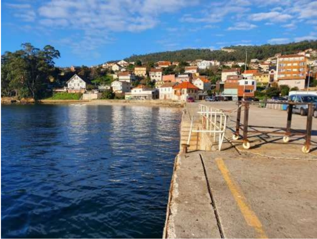
Imagen 47. Cara sur del muelle pesquero y escaleras de descarga situadas en su tramo final. Fuente: ACADAR
