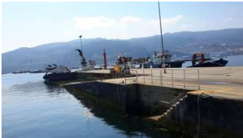
Figura 13. Muelle y rampa de descarga del puerto de Domaio
