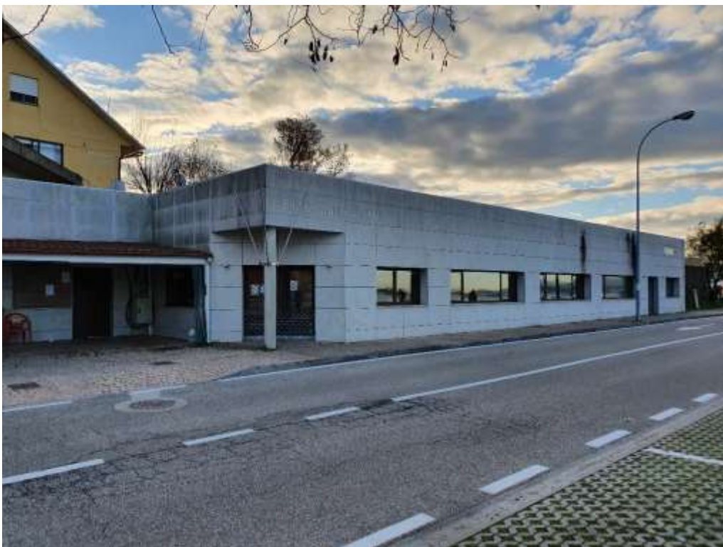
Imagen 24. Edificio multiusos del puerto de Meira. Fuente: ACADAR
