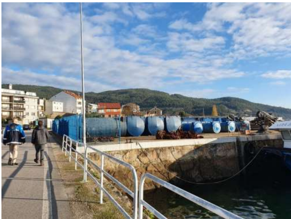
Imagen 30. Zona dedicada a la reparación y construcción de bateas en el puerto de Domaio. Fuente: ACADAR
