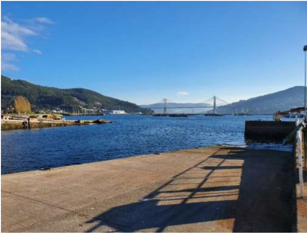
Imagen 49. Rampa de descarga ubicada en la zona pesquera. Fuente: ACADAR
