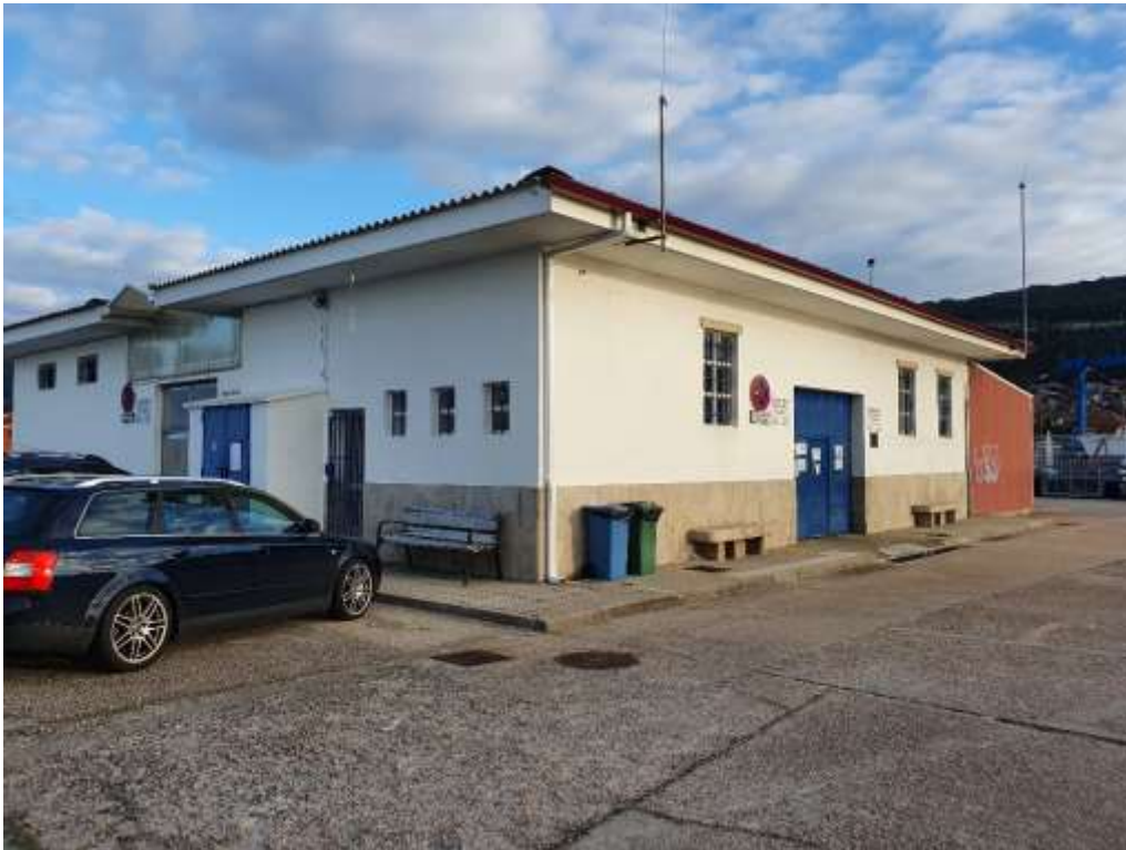
Imagen 13. Fachada sureste de la lonja del puerto de Meira. Fuente: ACADAR
