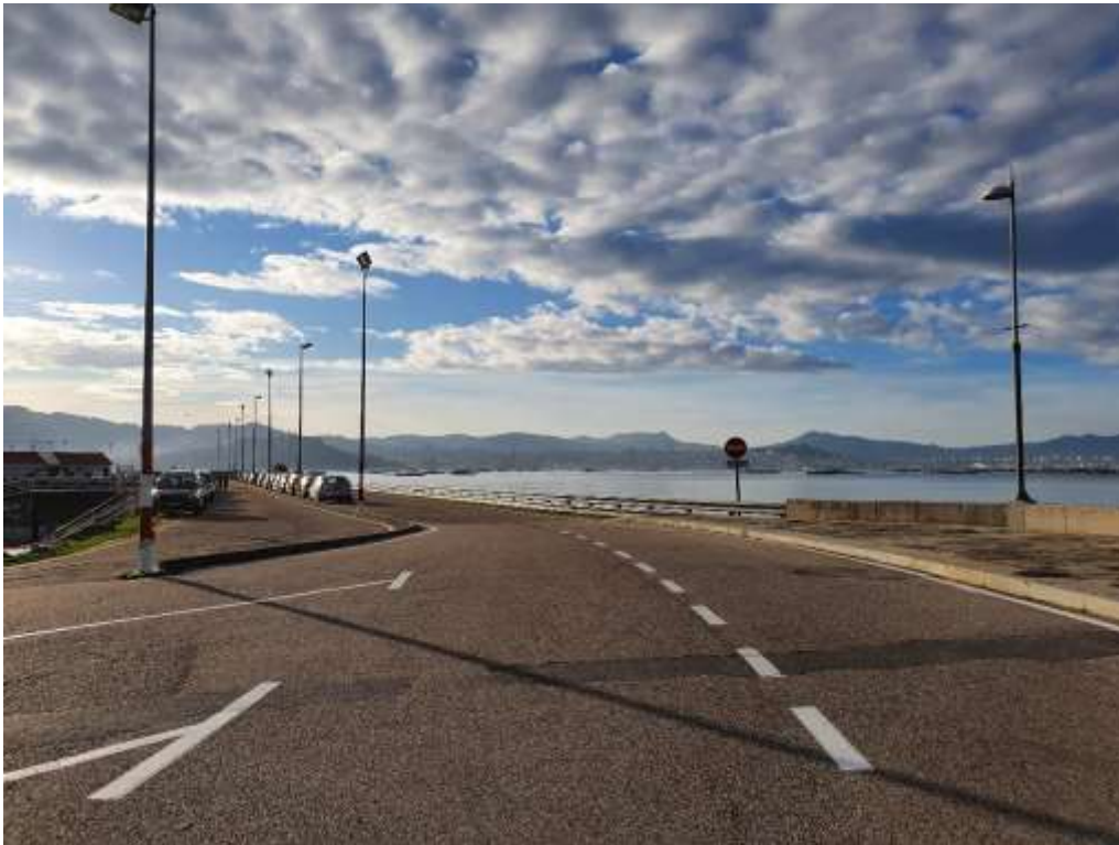
Imagen 23. Vial principal que discurre a lo largo de la obra de abrigo del puerto y a través del que se accede al pantalán principal y los departamentos. Fuente: ACADAR
