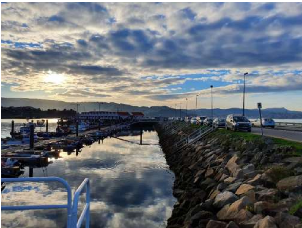
Imagen 6. Dique de abrigo desde el que se accede al pantalán principal del puerto. Fuente: ACADAR
