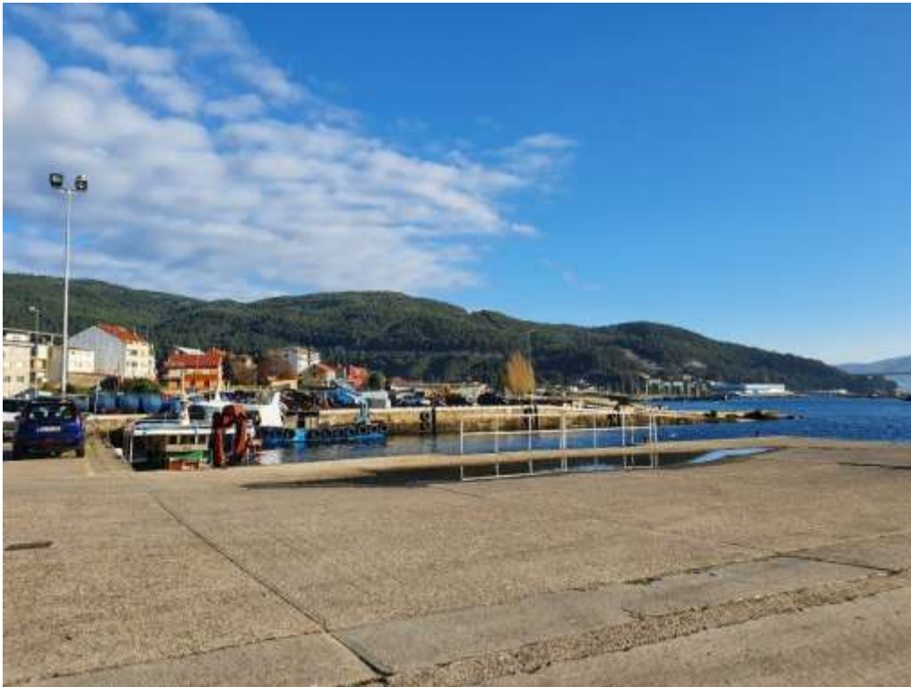
Imagen 51. Muelle y parte de la explanada de uso pesquero. Fuente: ACADAR
