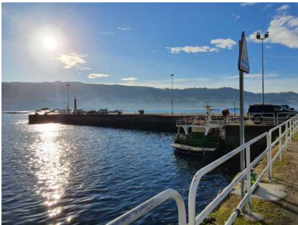
Imagen 28. Muelle y rampa de descarga del puerto de Domaio. Fuente: ACADAR
