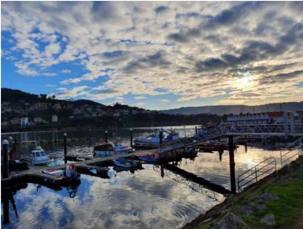
Imagen 9. Pasarela de acceso al pantalán principal del puerto de Meira. Fuente: ACADAR
