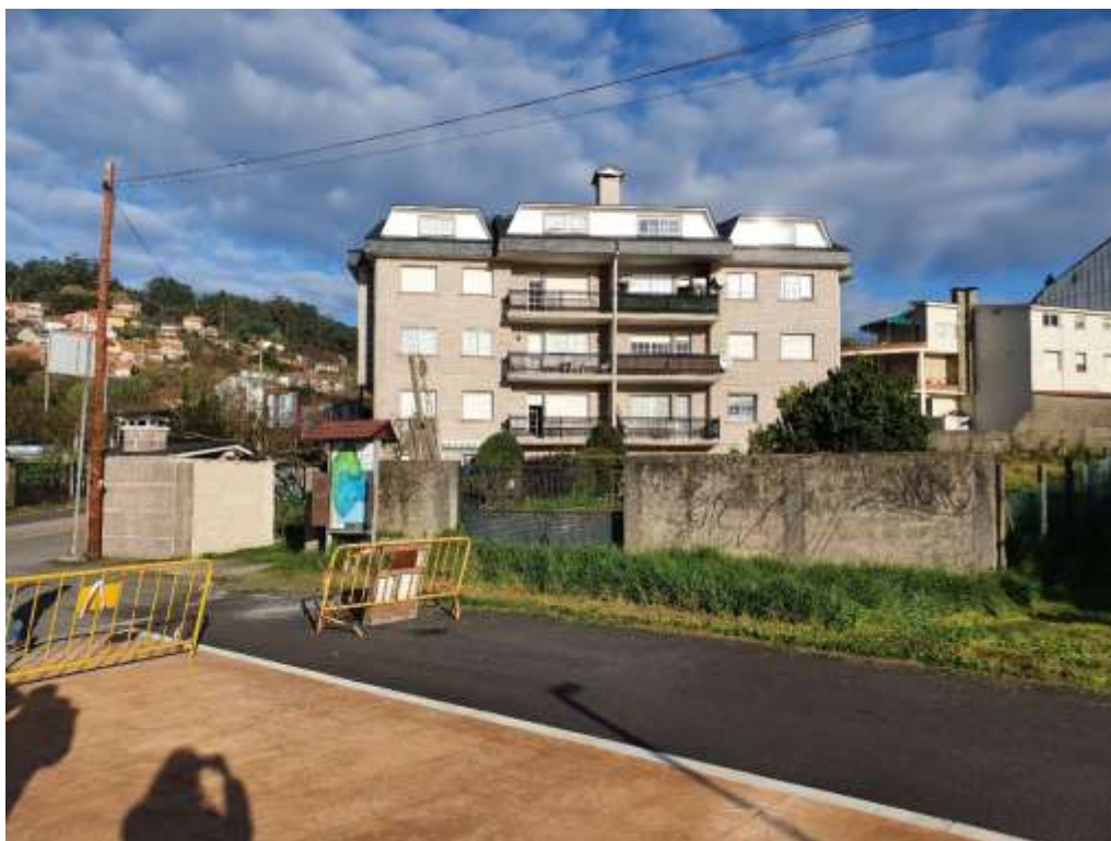
Imagen 36. Acceso al puerto en la zona norte e Inicio de la senda peatonal. Fuente: ACADAR
