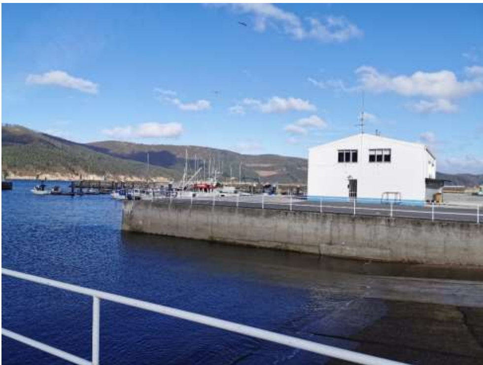
Imagen 16. Rampa de varada y lonja. Fuente: ACADAR
