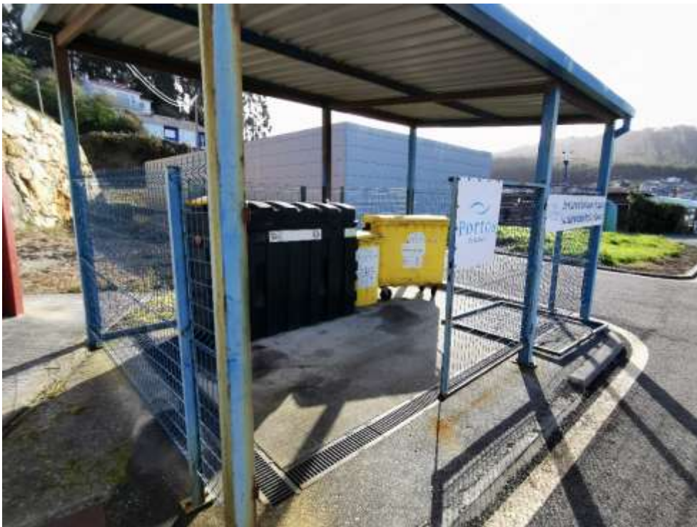
Imagen 21. Contenedores de residuos Marpol del puerto de O Vicedo. Fuente: ACADAR
