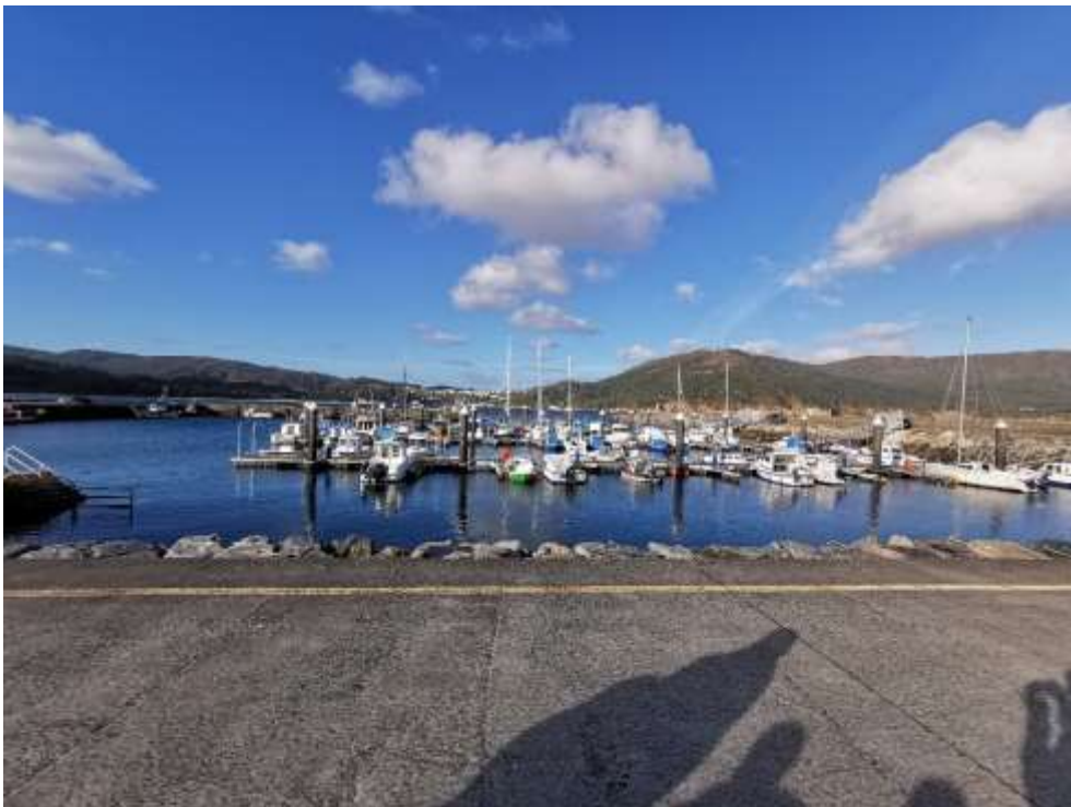
Imagen 6. Pantalanes embarcaciones náutico-deportivas. Fuente: ACADAR
