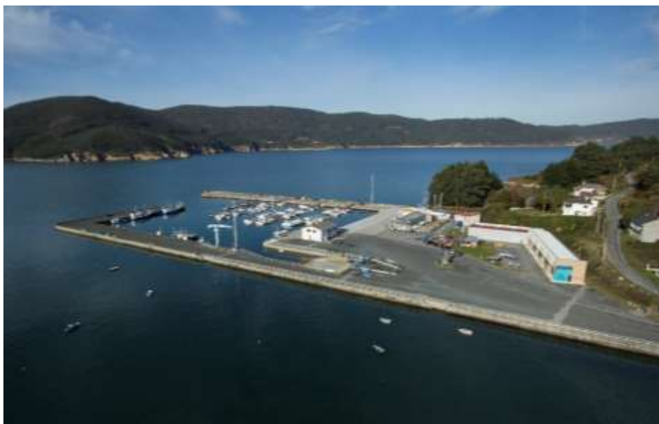
Figura 1. Vista aérea del puerto de O Vicedo
