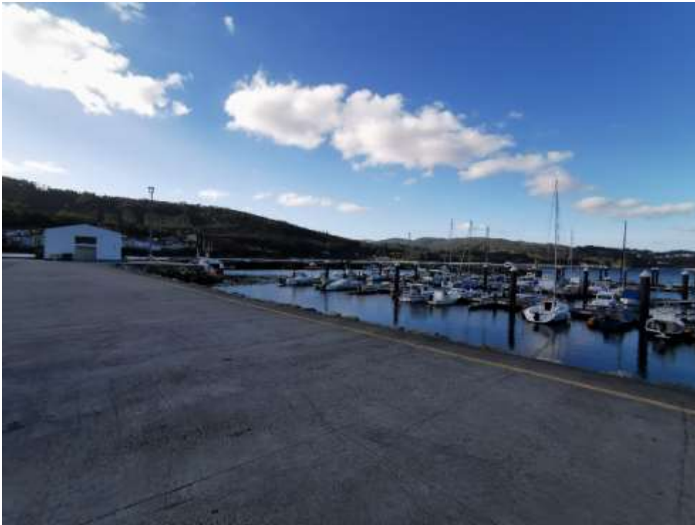
Imagen 13. Vista general del puerto. Fuente: ACADAR
