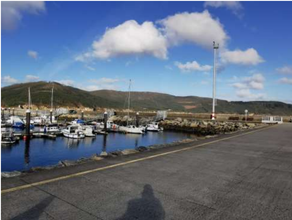
Imagen 7. Parte interior del dique de abrigo y acceso a los pantalanes. Fuente: ACADAR
