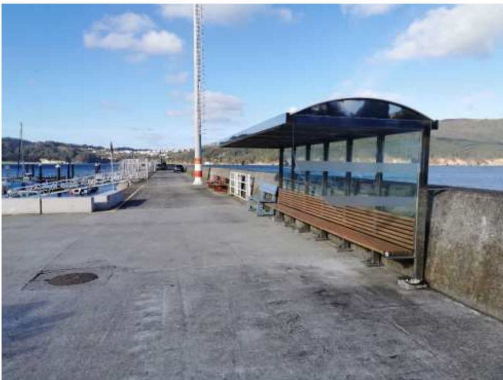
Imagen 10. Marquesina y bancos para usuarios ubicados en el arranque del dique. Fuente: ACADAR
