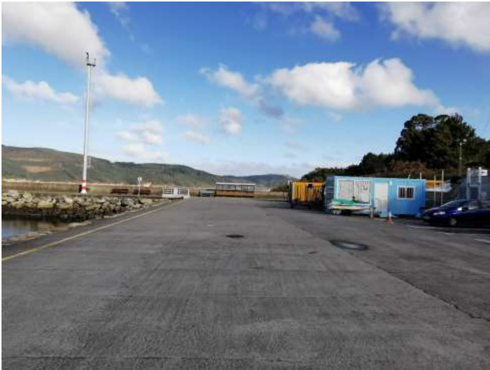
Imagen 9. Explanada principal. Fuente: ACADAR
