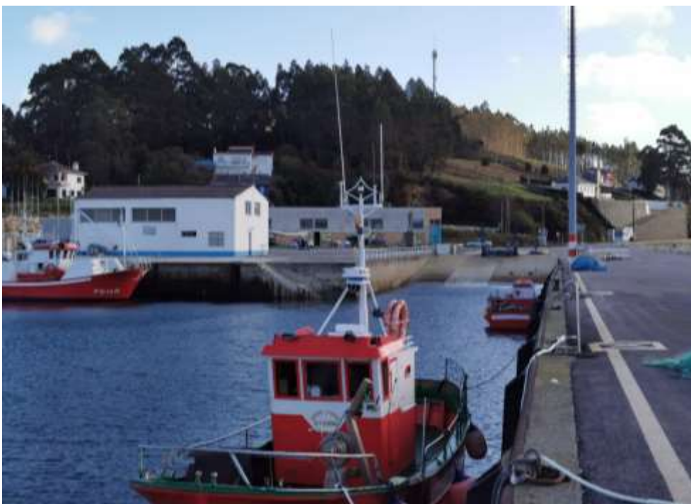
Imagen 19. Barcos atracados en el muelle pesquero, rampa de varada mixta y lonja y departamentos de pescadores (al fondo). Fuente: ACADAR
