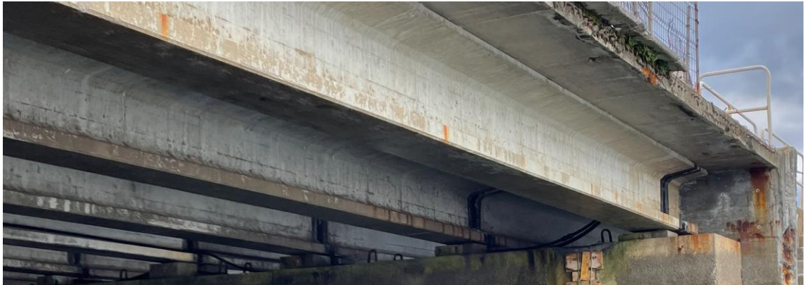
Fig. 8. Vigas doble T en la zona interior del muelle.
