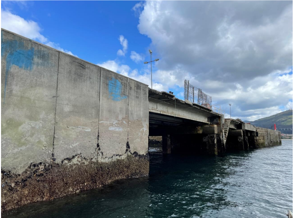
Fig. 4. Planta del muelle de Mejilloneros (en rojo la zona deteriorada).
