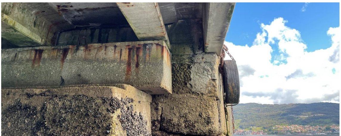
Fig. 15. Apoyo del panel corto en el muro.
