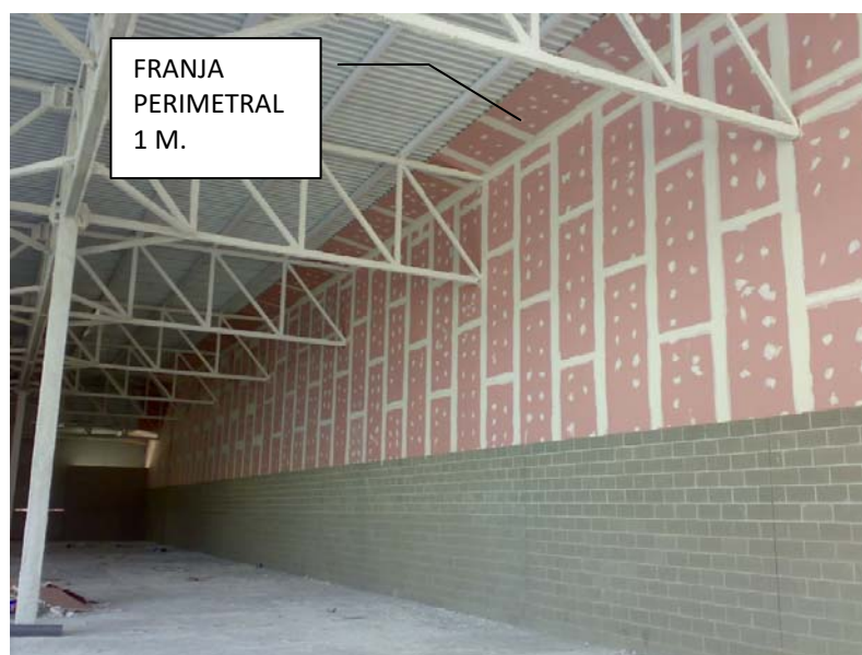
Franja de cubierta de 1 m con placas de yeso laminado resistentes al fuego.
