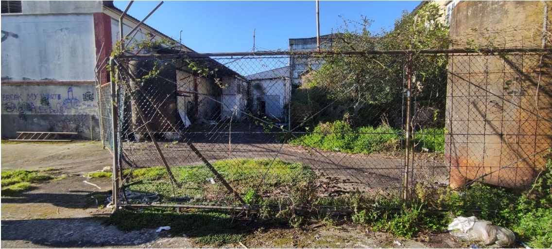
Zona para desmantelar, desbrozar y limpiar.
