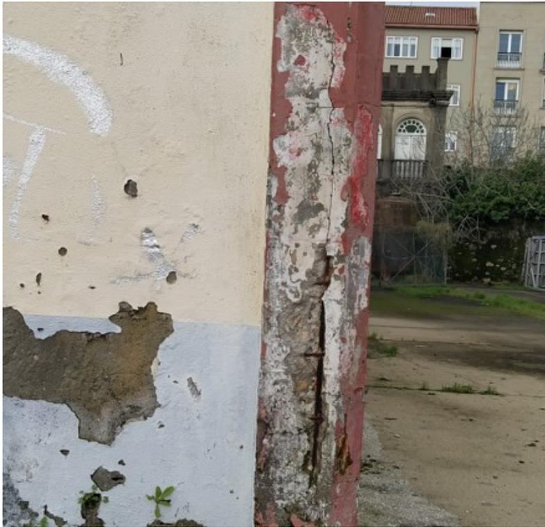
Por otra parte, si el medio ambiente en el que se encuentra el propio hormigón armado contiene materias o productos corrosivos para el acero, como sucede en las zonas marítimas en la que nos encontramos, la protección que la alcalinidad actual y potencial que el hormigón confiere a las armaduras puede no ser suficiente y éstas se corroen.
