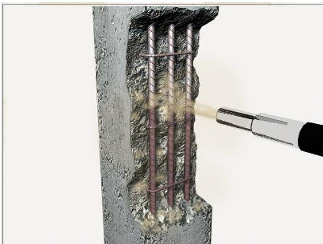
3. Relleno: aplicación de pasivante MasterEmaco P 5000 AP, (pasivador de armaduras y puente de unión para morteros de reparación), aplicado con medios manuales sobre la superficie expuesta. Incluso reposición de armaduras donde la pérdida de sección sea superior al 15%.
