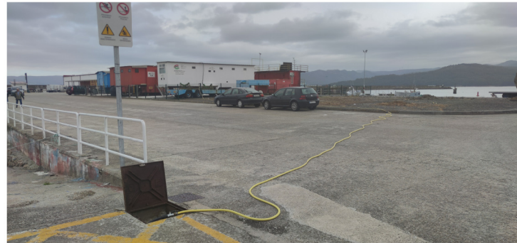
CONEXIÓN ABASTECIMIENTO (MANGUEIRA PROVISIONAL ACTUAL)
