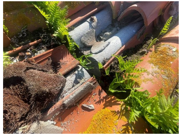
Figura 20. Vista en detalle del encuentro de la cubierta de teja cerámica con el canalón interior.
