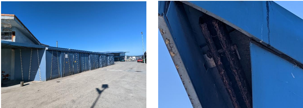
Figura 28. Puertas correderas que presentan dificultades de apertura (izda.) y guía metálica de las mismas (dcha.).
