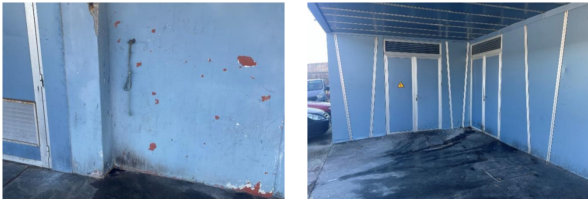
Figura 12. Vista exterior de cerramiento en zona original (izda.) y ampliación (dcha.)
