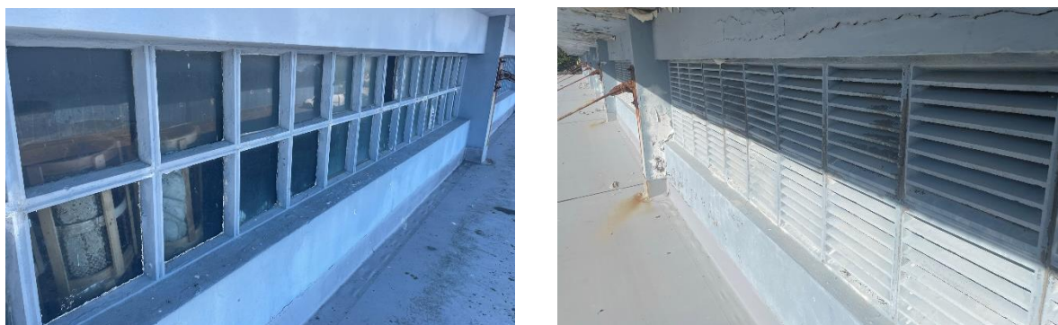
Figura 14. Ventanal (izda.) y lamas (dcha.) sobre la línea de voladizo
