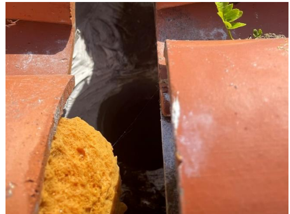
Figura 21. Vista en detalle del encuentro del canalón con las bajantes interiores.
