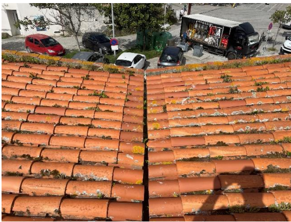
Figura 20. Vista en detalle del encuentro de la cubierta de teja cerámica con el canalón interior.
