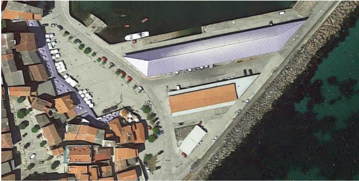
Figura 3. Localización del edificio al sur del puerto de Fisterra.
