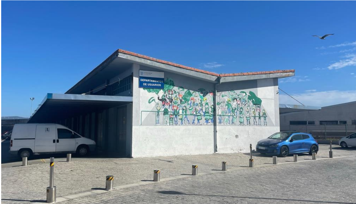
Figura 5. Vista del edificio desde el oeste.
