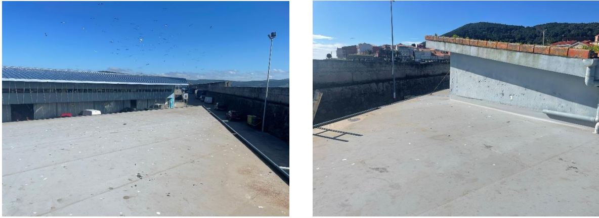
Figura 24. Vista general de la cubierta plana en extremo este de edificio.
