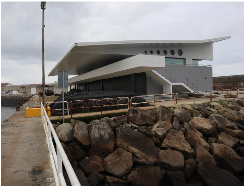
Fotografía de la cubierta sobre la pasarela (2024).
