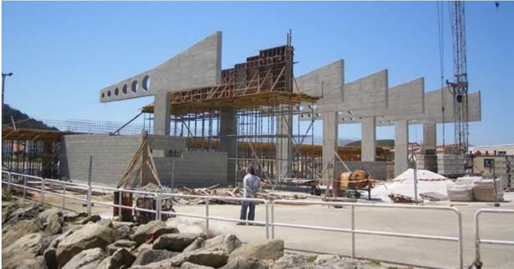
Fotografía de la construcción de los pórticos de hormigón (Mónica Balado)
