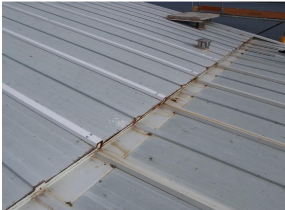
Figura 7. Imagen de solapamiento en cambio de pendiente
