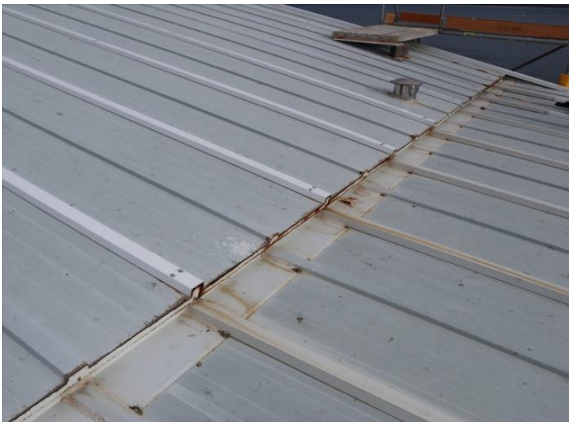
Fig.3. Imagen de solapamiento en cambio de pendiente.
