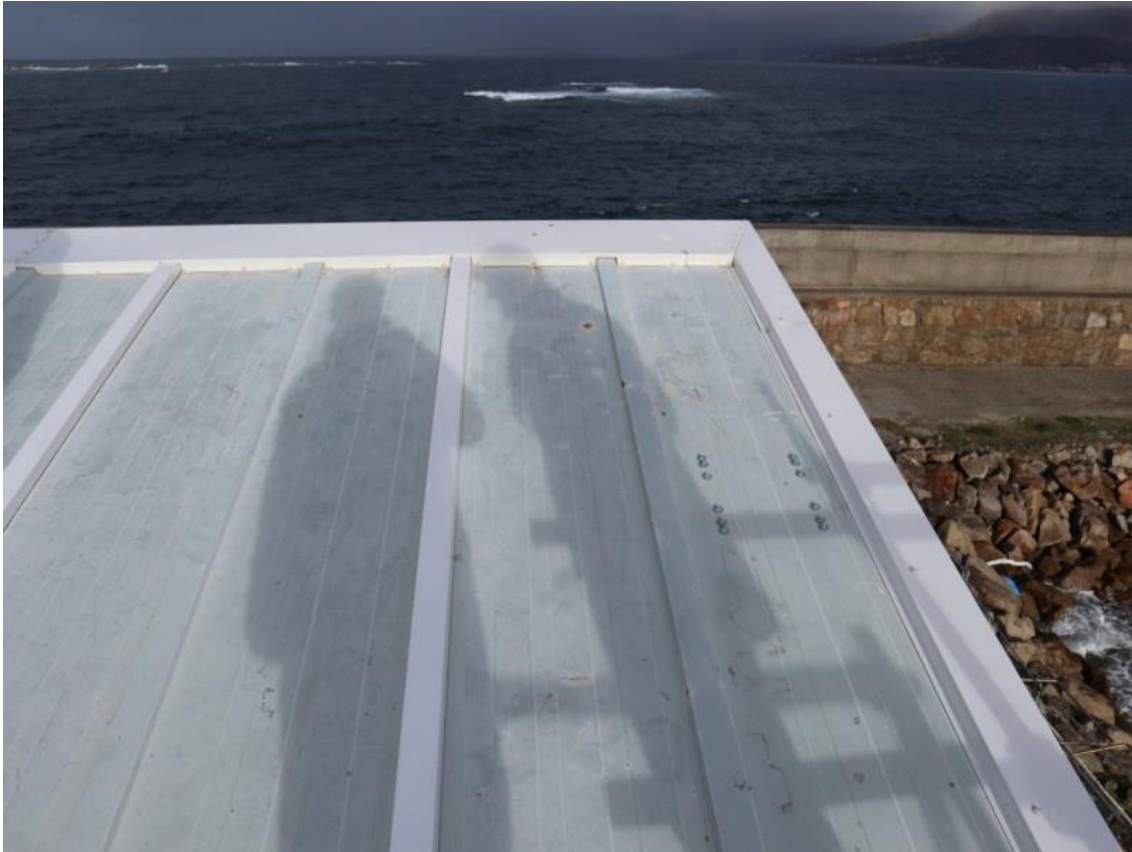
Fig.1. Imagen remate superior de cubierta.
