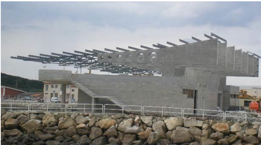
Fotografía de la construcción de la estructura metálica (Mónica Balado)
