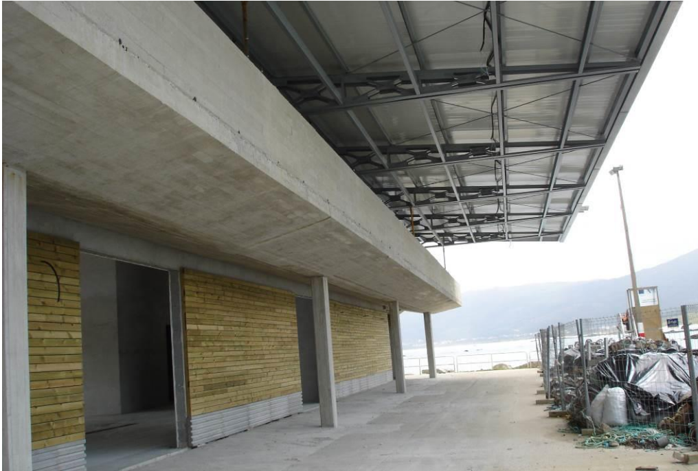
Fotografía del proceso constructivo (facilitada por el estudio de Gallego Jorreto)
