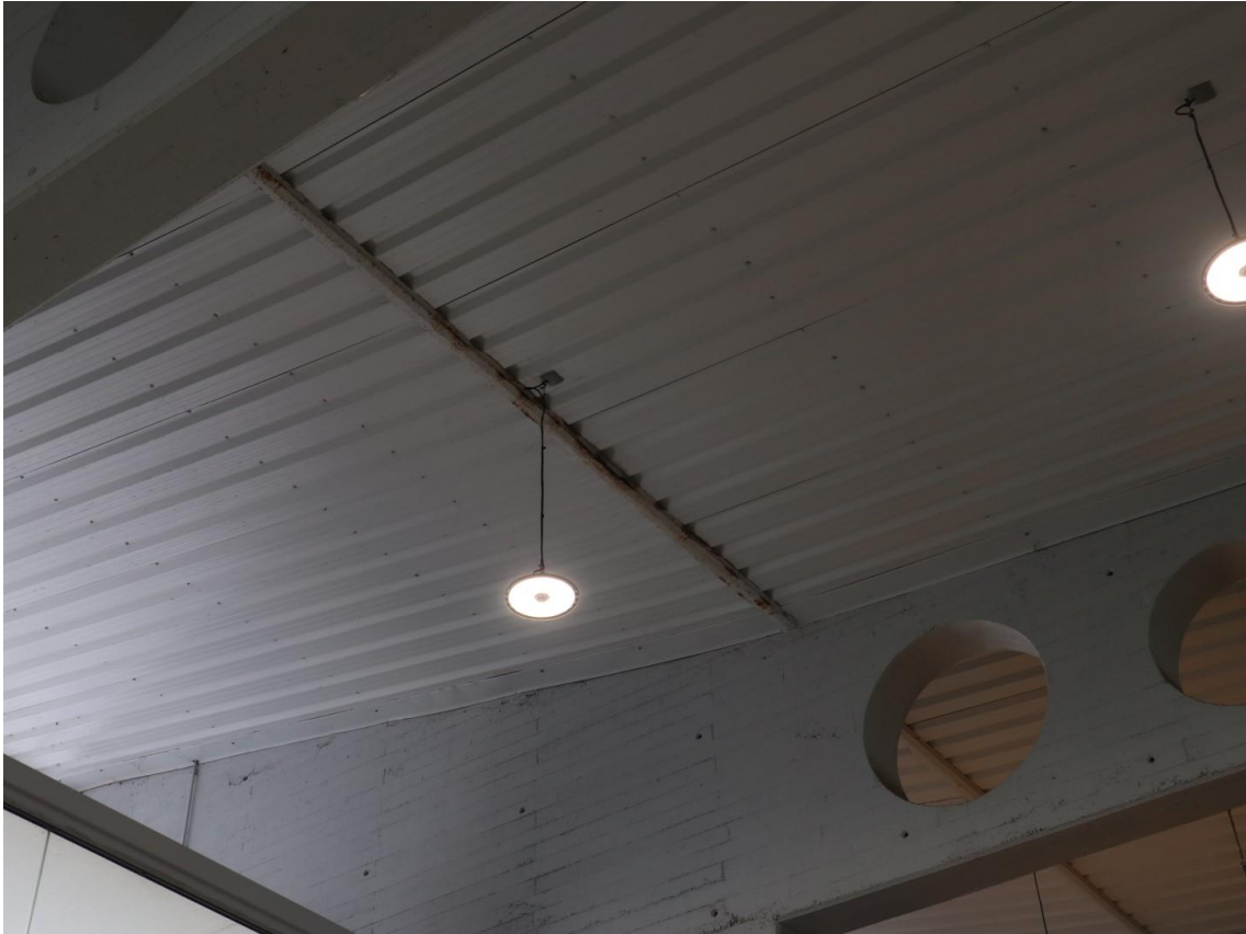
Fig.7. Remate interior F.T. cambio de pendiente.
