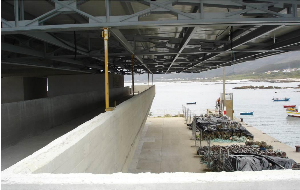
Fotografía del proceso constructivo (facilitada por el estudio de Gallego Jorreto)
