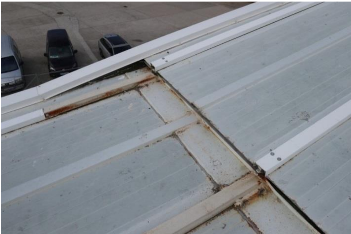
Fig.2. Imagen encuentro de cambio de pendiente de cubierta.
