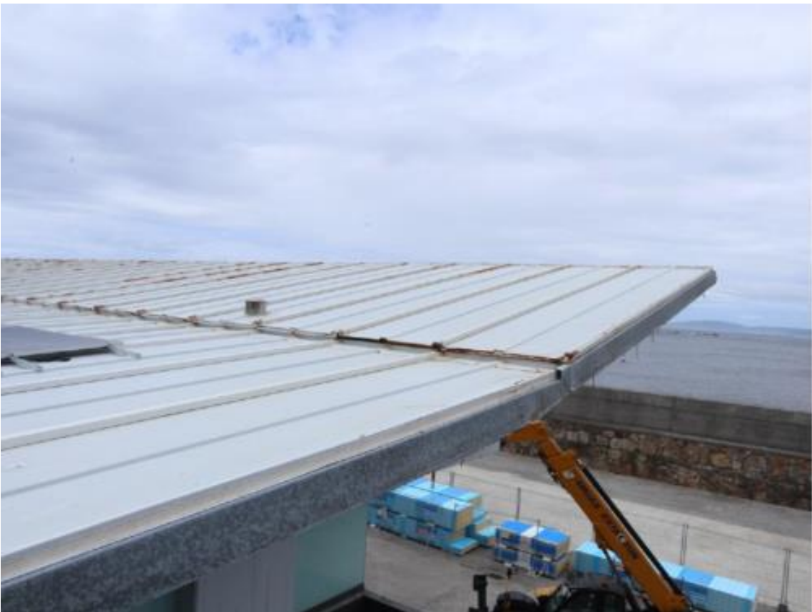
Fig.6. Imagen borde corto de cubierta.
