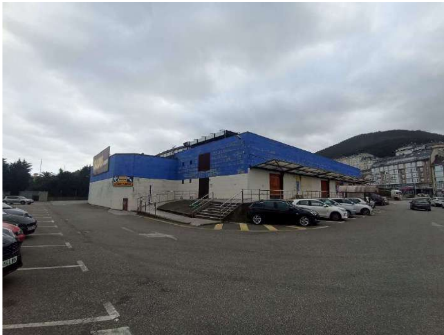
Detalle fachada lateral izquierda – marquesina
