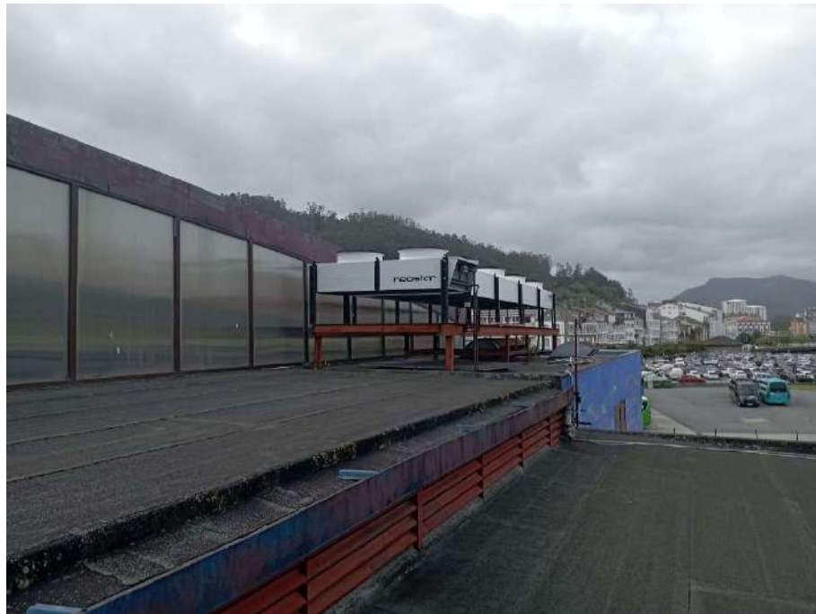
Cubierta. Condensadora frigorífica a renovar
