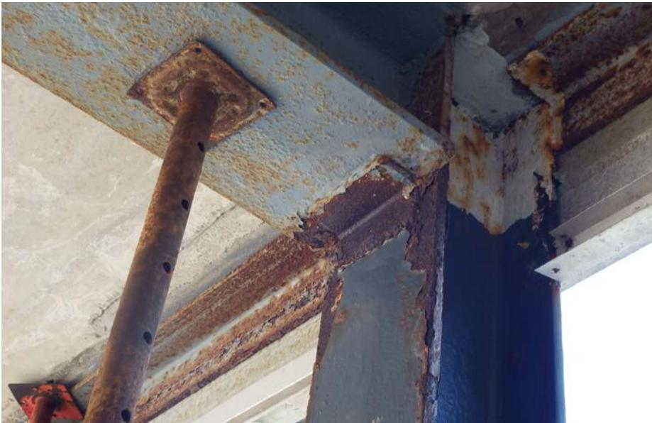
Tal y como se observa en la fotografía del nudo de unión, no se han colocado los rigidizadores, ni la chapa superior, ni el angular de apoyo que recibe a la viga está en todo el ancho del ala del soporte, por tanto se procede a realizar las comprobaciones del pórtico central, para ambas situaciones, la de proyecto y la ejecutada en obra.
