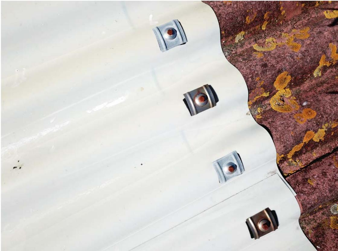
Encuentro de cubierta con panel traslúcido y planchas de fibrocemento
