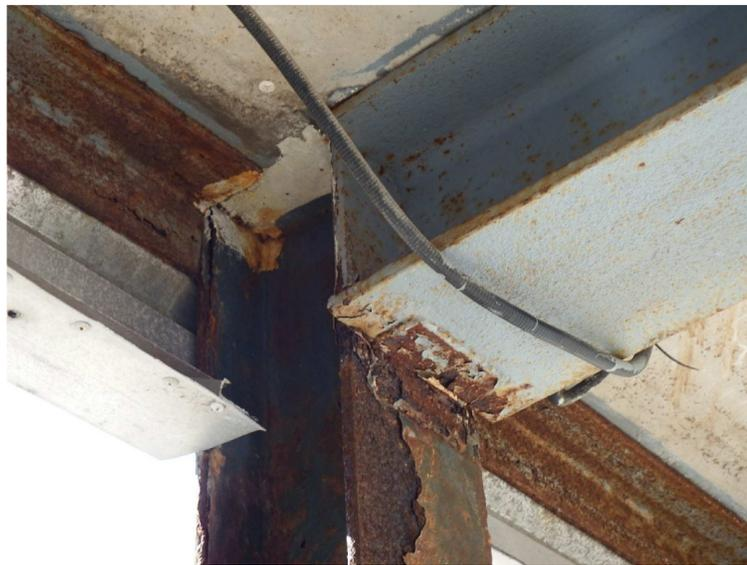
FOTO 1. Unión soporte viga en porche acceso suroeste
