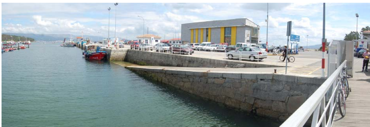
Figura 6. Vista del muelle pesquero y de una de las rampas de descarga de la dársena interior.
