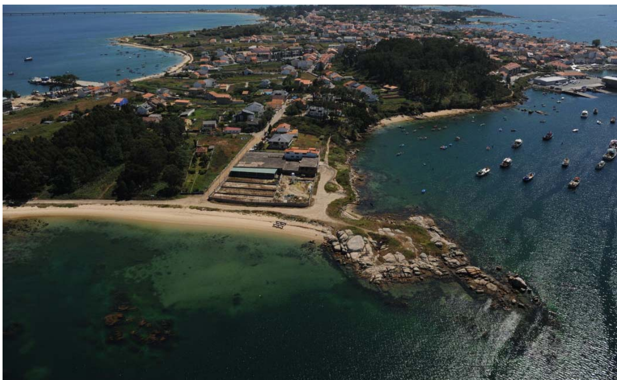
Foto 6. Vista de la dársena exterior antes de la construcción del dique y explanada - varadero.
