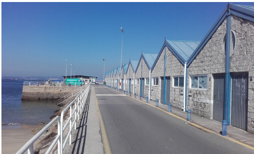
Vista de explanada del dique y vial principal (dirección vuelta). A la derecha: naves departamentos
