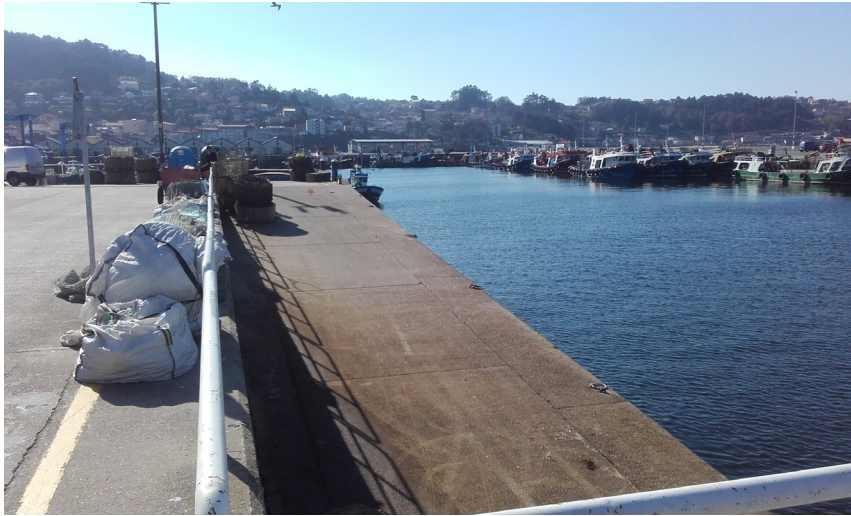
Rampa de descarga de la zona pesquera
