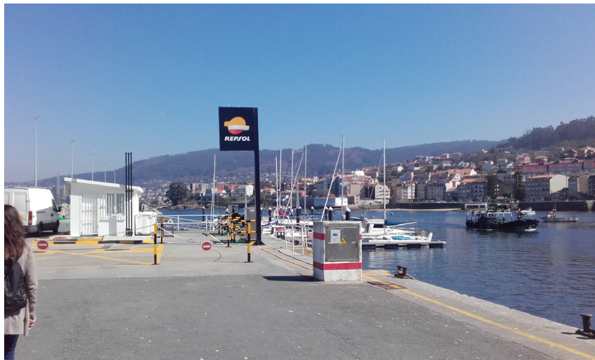
Detalle surtidor de combustible para embarcaciones
