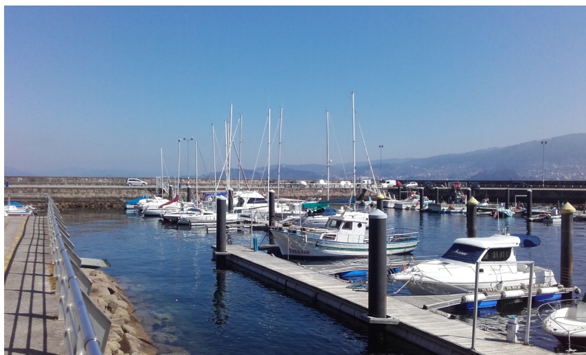
Pantalán 1 del muelle sur. Al fondo: dique de abrigo
