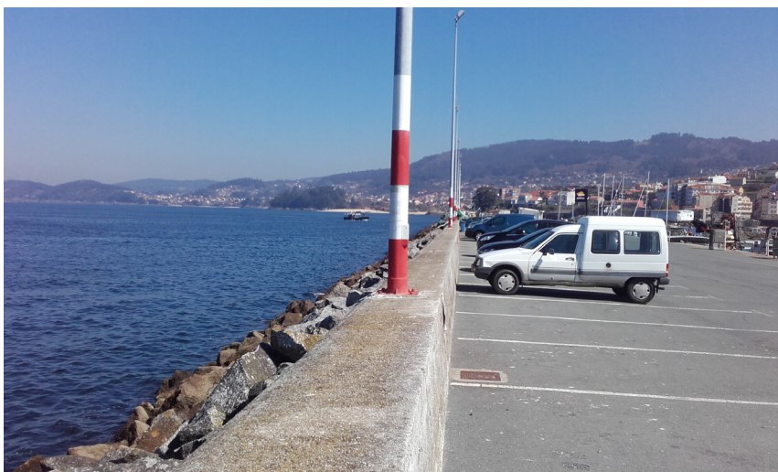
Vista de escollera del dique y aparcamiento
