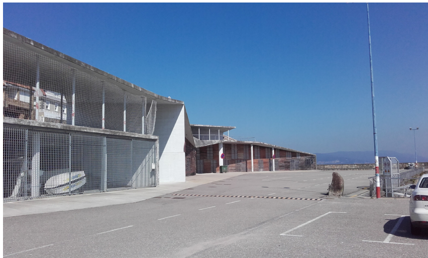
Vial principal y aparcamientos. A la izquierda: Instalaciones del club de remo. Al fondo: departamentos de usuarios
