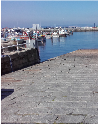
Rampa adoquinada para carga y descarga
