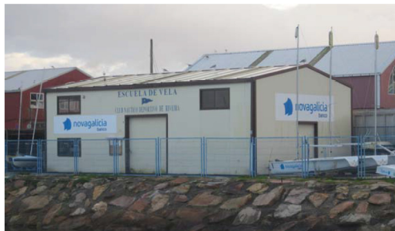
Edificación de la escuela de vela
