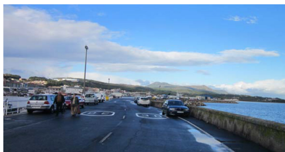
Vial interno del dique de abrigo
