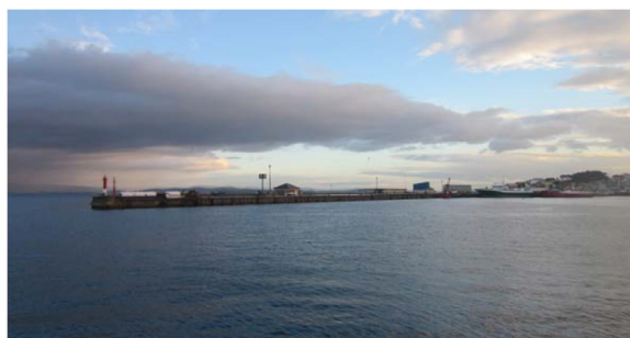
Vista general del dique de abrigo
