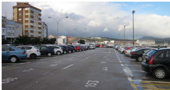
Vial de acceso a la zona de pantalanes
