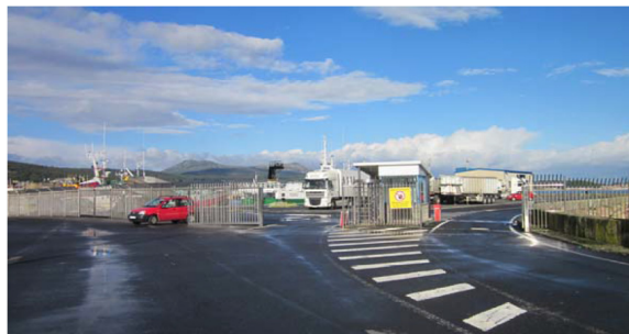
Control de accesos al muelle comercial del dique
