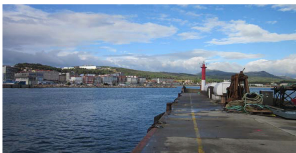
Vista general de la parte final del dique
