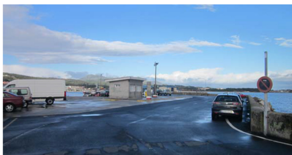
Acceso al vial del dique y caseta de la báscula
