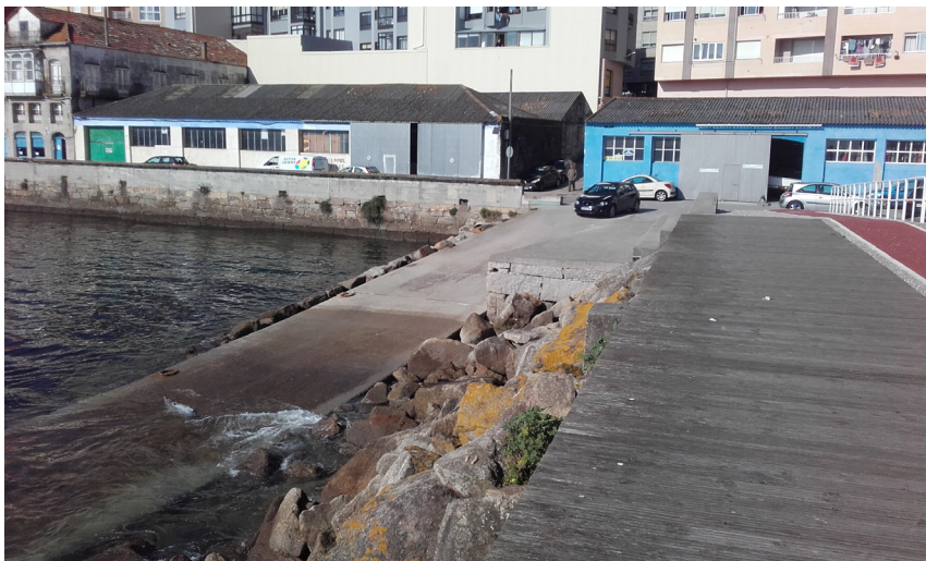
Rampa anexa al dique
