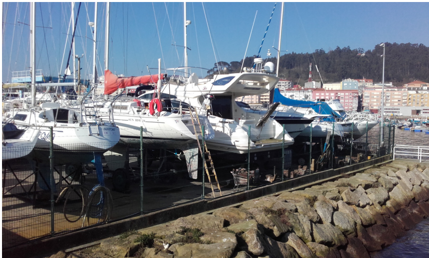
Zona de varada anexa al dique (I)
