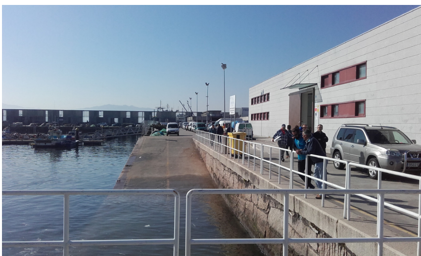
Lonja de Cangas y rampa para descargas
