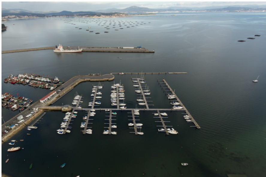
Imagen 3. Imagen aérea del Puerto deportivo de A Pobra do Caramiñal
