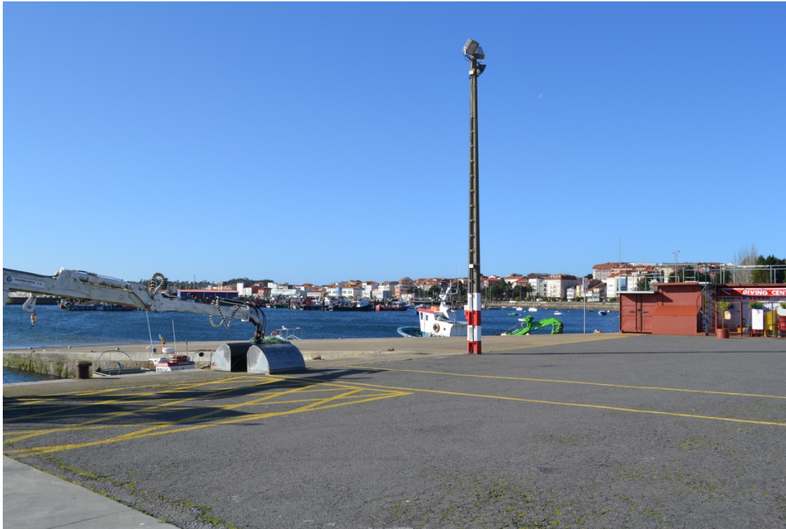
Imagen 11. Rampa de varada y muelle pesquero
