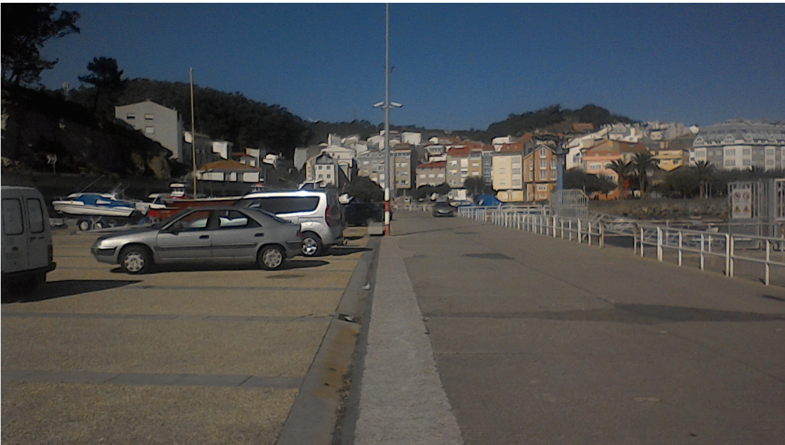
Imagen 15. Puerto de Corme. Vista general del muelle.
