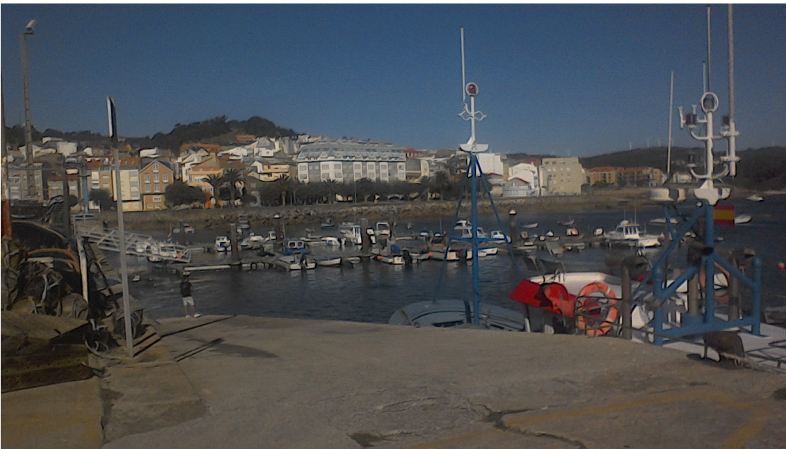
Imagen 21. Puerto de Corme. Pantalanés.
