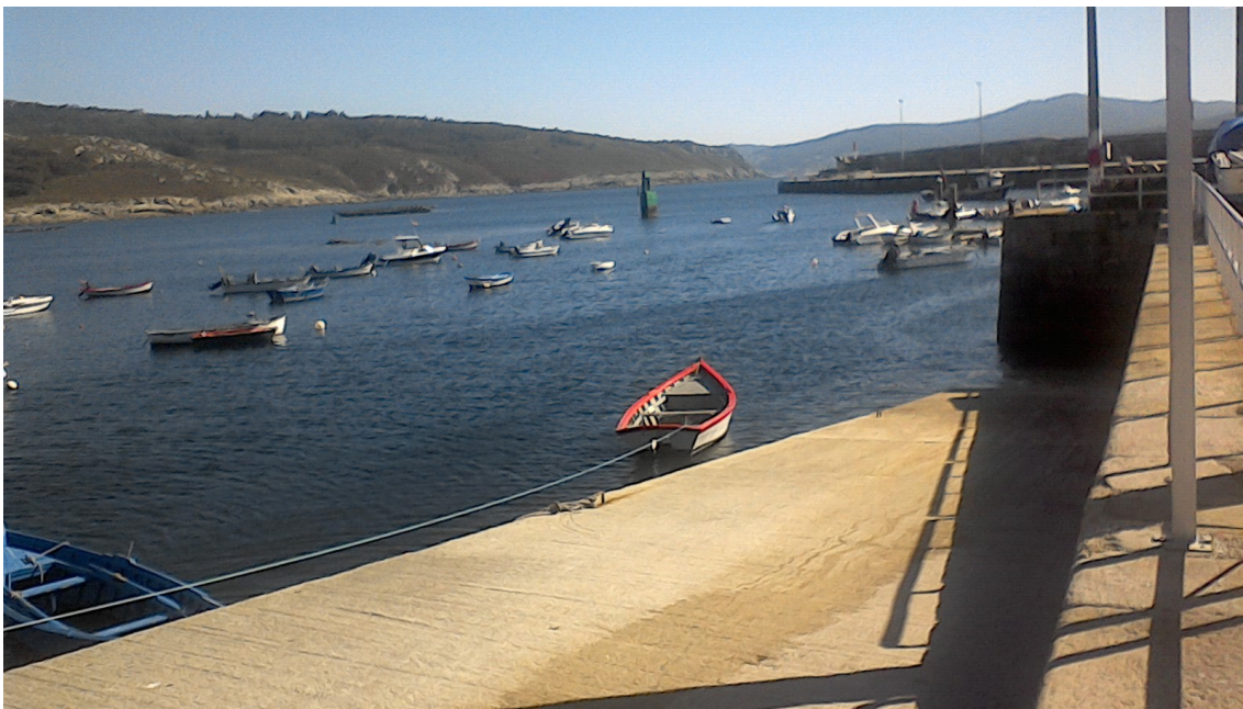
Imagen 9. Puerto de Corme. Rampa del muelle pesquero.
