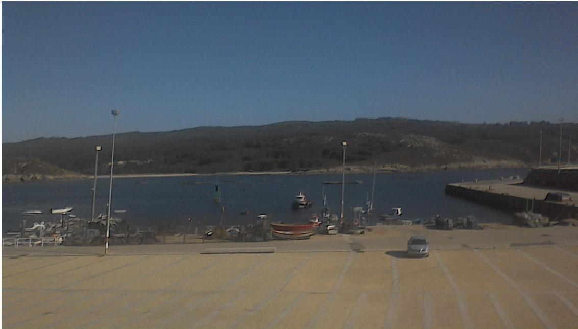
Imagen 18. Puerto de Corme. Vista general del muelle
