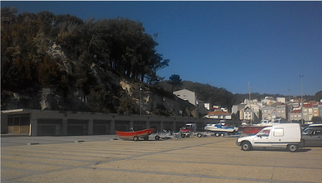
Imagen 16. Puerto de Corme. Vista general del muelle.
