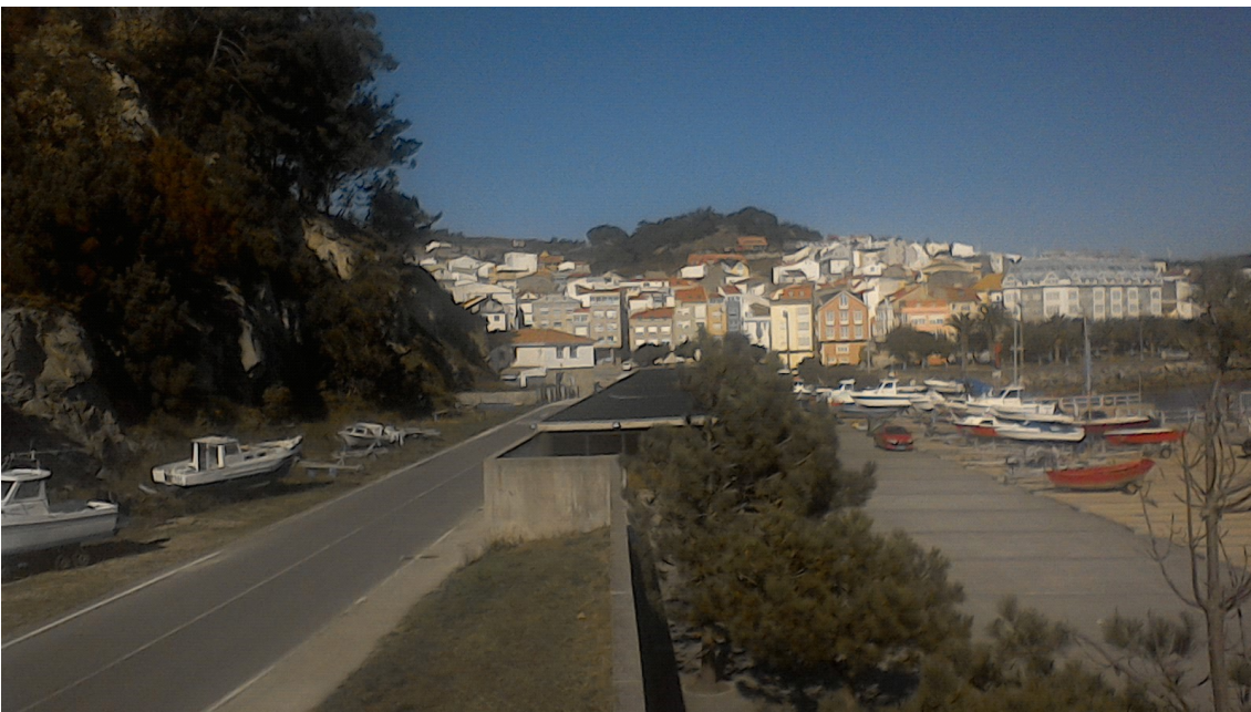
Imagen 17. Puerto de Corme. Vista general del muelle y departamentos
