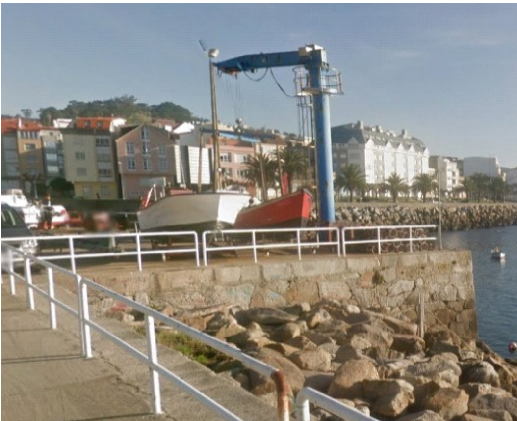
Imagen 23. Puerto de Corme. Grúa.
