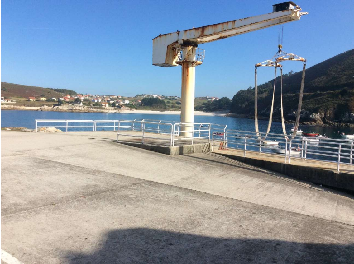
Imagen 35. Acceso a la grúa
