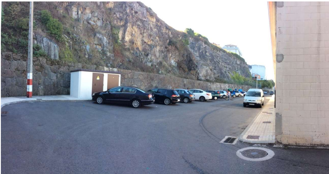
Imagen 29. Vial trasero a los departamentos ubicados en el muelle sur.
