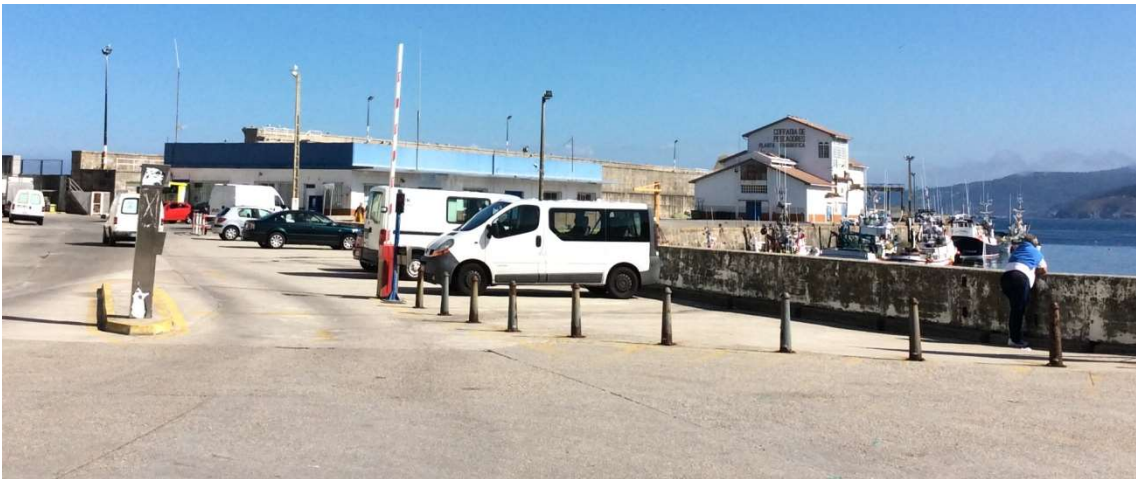
Imagen 13. Control de acceso y vista parcial del muelle sur.
