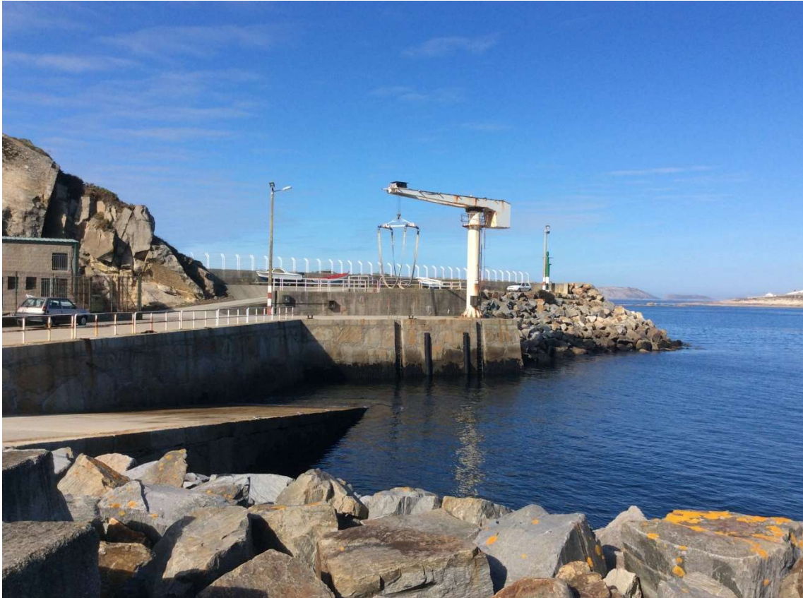
Imagen 31. Vista general del dique y grua. A la izquierda la rampa de acceso.
