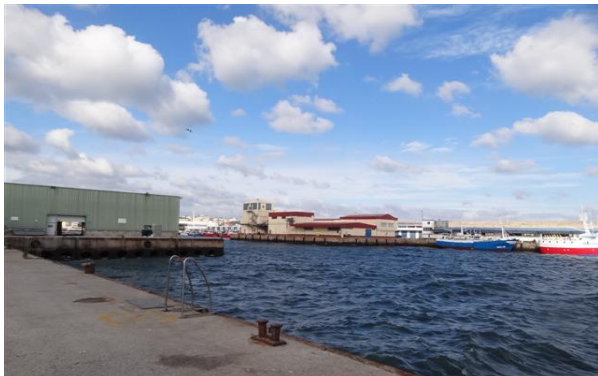
Fábrica de hielo y cámaras frigoríficas
