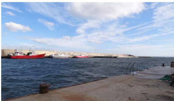
Vista general del muelle comercial
