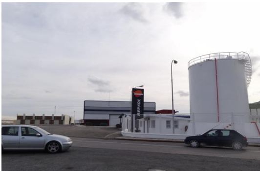
Instalación de suministro de combustible
