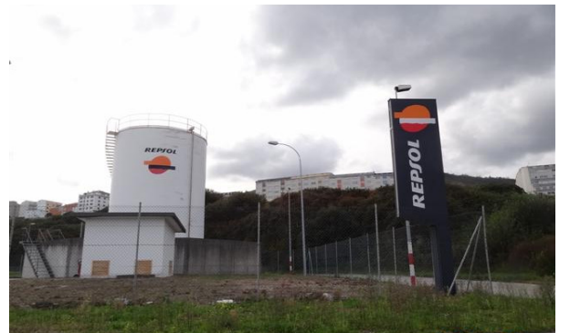
Instalaciones de suministro de combustible
