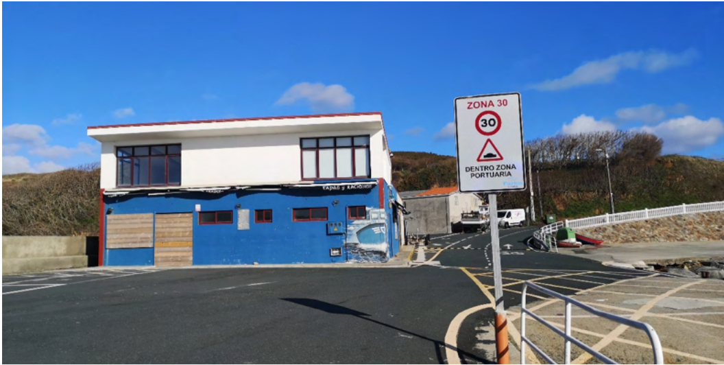
Imagen 49. Vial de acceso del puerto de Espasante y edificaciones existentes. Fuente: ACADAR
