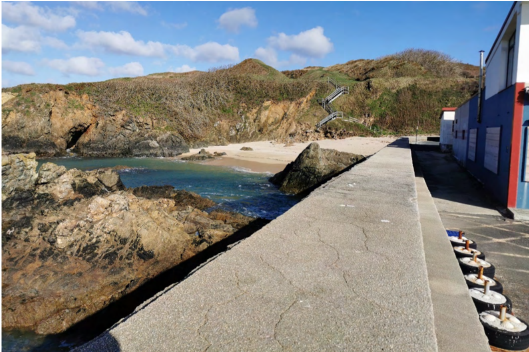
Imagen 51. Zona de servicio del puerto ubicada tras la lonja y cetárea del puerto. Fuente: ACADAR
