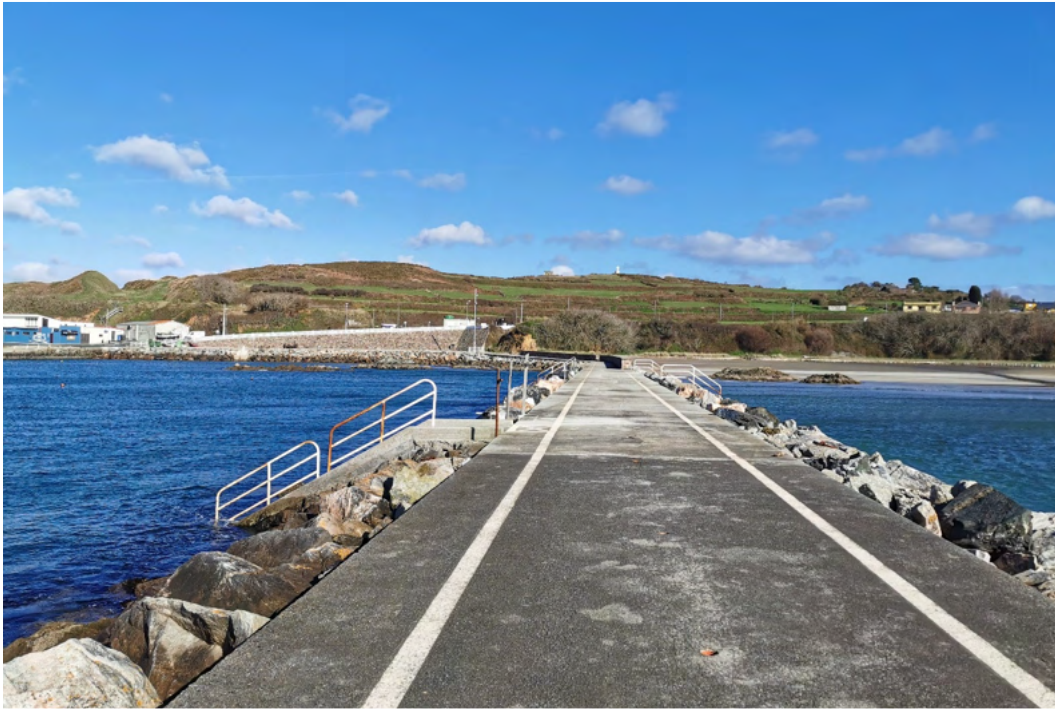
Imagen 65. Contradique de abrigo. Fuente: ACADAR
