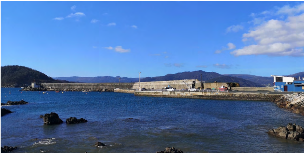
Imagen 46. Vista general del puerto de Espasante desde el contradique de abrigo. Fuente: ACADAR
