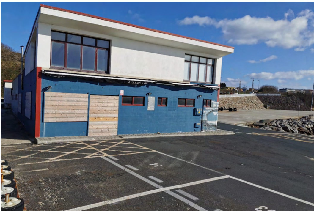
Imagen 48. Edificación que aloja un bar en concesión en la planta baja. Fuente: ACADAR
