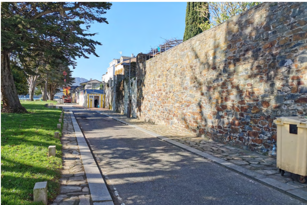
Imagen 26. Vial interior del puerto y muros que delimitan la zona de servicio del puerto en la franja norte. Fuente: ACADAR
