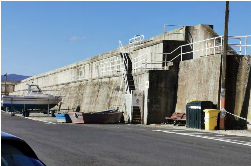
Imagen 52. Espaldón de la primera alineación del dique de abrigo y zona de varada de embarcaciones. Fuente: ACADAR
