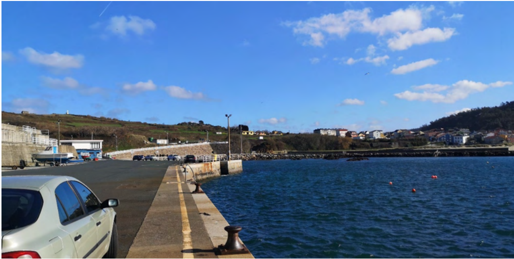
Imagen 59. Muelle principal del puerto de Espasante, explanada anexa y zona norte de la dársena. Fuente: ACADAR
