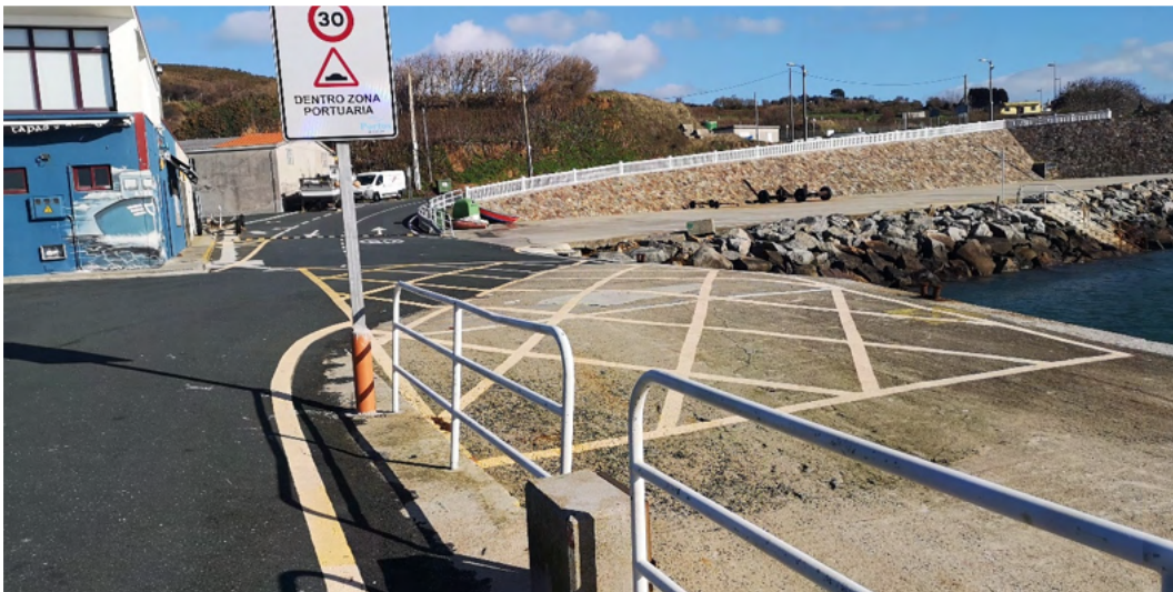
Imagen 58. Detalle de la parte superior de la rampa y vial de acceso. Fuente: ACADAR
