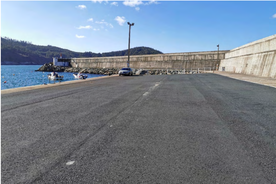
Imagen 55. Muelle y explanada principal del puerto y segunda alineación del dique de abrigo. Fuente: ACADAR
