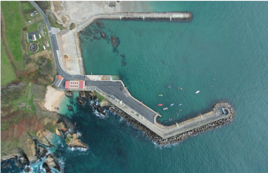
Imagen 42. Puerto de Espasante (vista cenital) desde el aire en 2013. Fuente: Portos de Galicia
