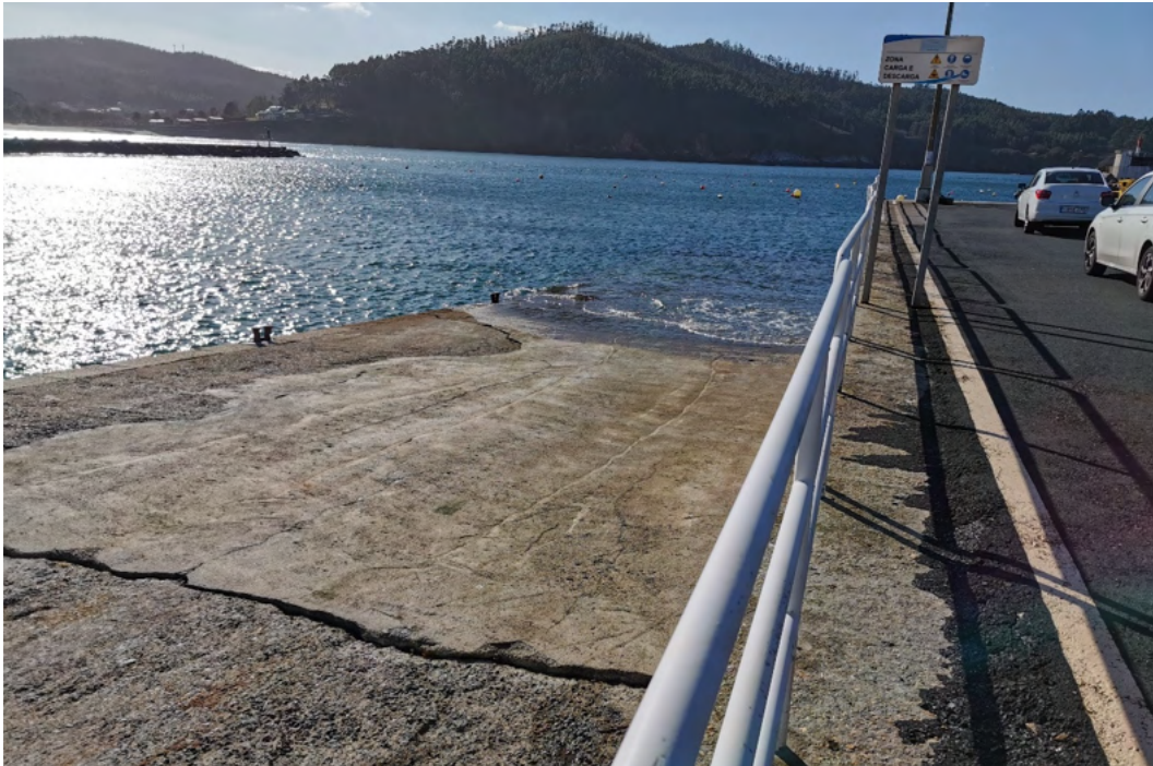
Imagen 57. Rampa de varada y descarga del puerto de Espasante. Fuente: ACADAR
