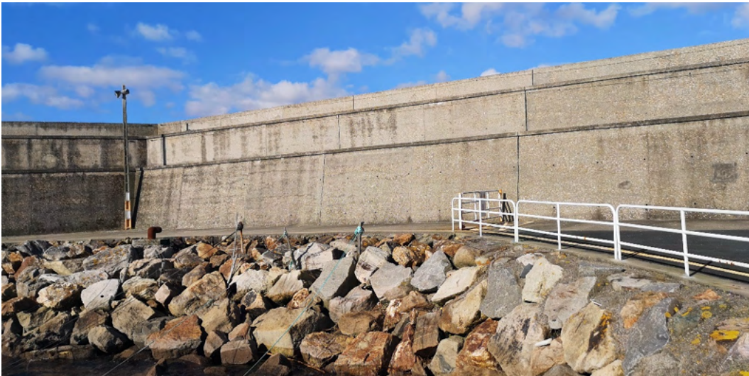
Imagen 56. Zona no transitable del dique de abrigo y detalle del espaldón. Fuente: ACADAR
