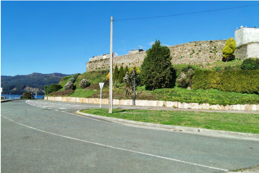
Imagen 39. Vial de acceso a la zona oeste del puerto de Ortigueira. Fuente: ACADAR
