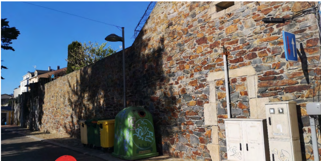
Imagen 28. Detalle de los muros de las viviendas limítrofes en la zona norte de la zona de servicio. Fuente: ACADAR
