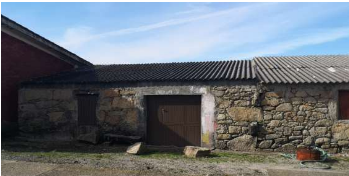
Imagen 10. Detalle de una de las puertas a entrada a las viejas edificaciones ubicadas en el interior del puerto. Fuente: ACADAR
