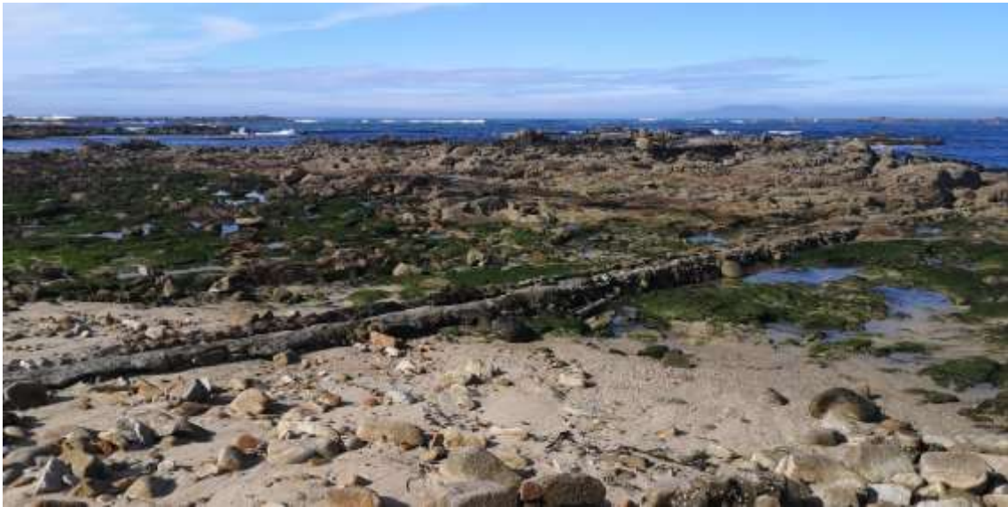
Imagen 37. Emisarios ubicados dentro de la zona de servicio del puerto. Fuente: ACADAR
