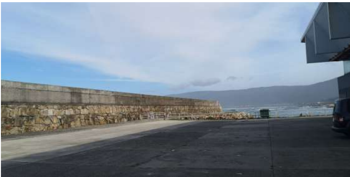
Imagen 33. Espaldón y zona del morro del dique de abrigo del puerto de Portocubelo. Fuente: ACADAR
