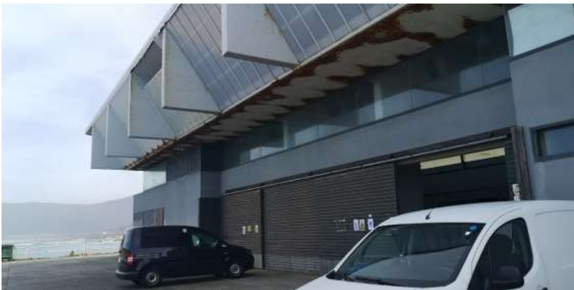
Imagen 24. Estado actual de la fachada norte de la lonja. Fuente: ACADAR
