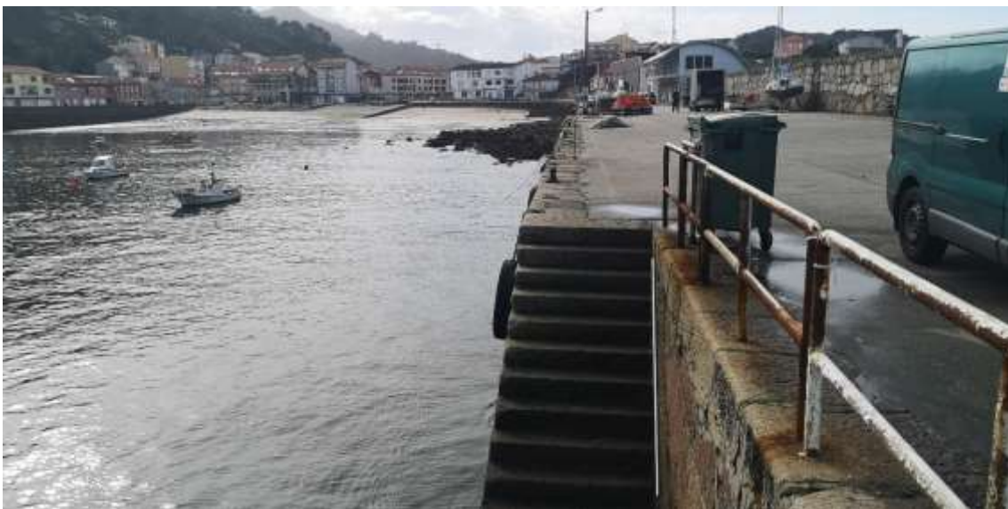
Imagen 72. Vista general del muelle y escaleras de descarga. Fuente: ACADAR
