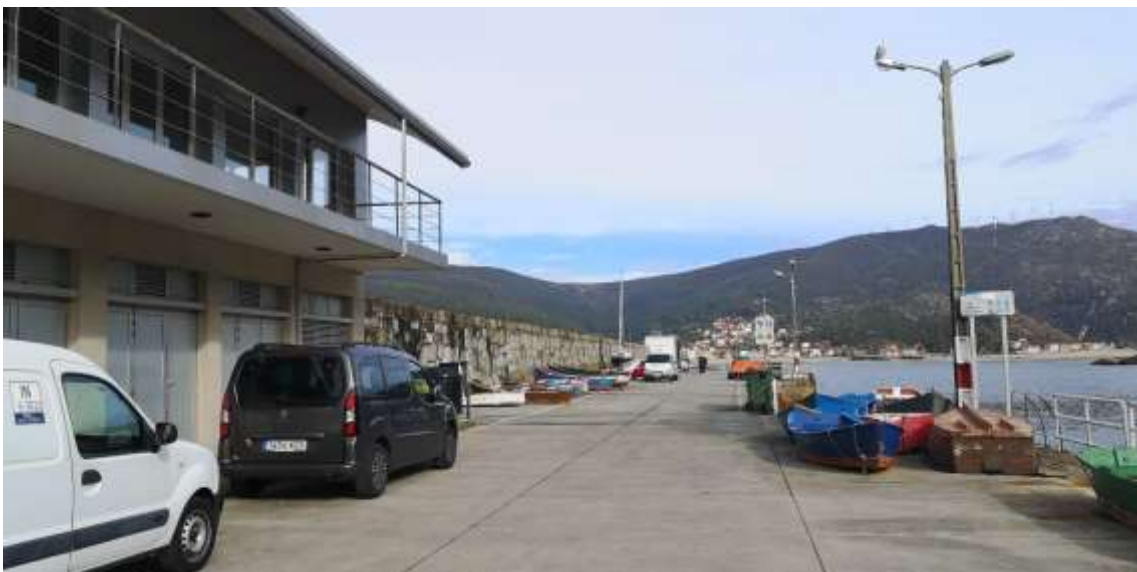
Imagen 54. Estado actual del puerto de O Pindo. Fuente: ACADAR
