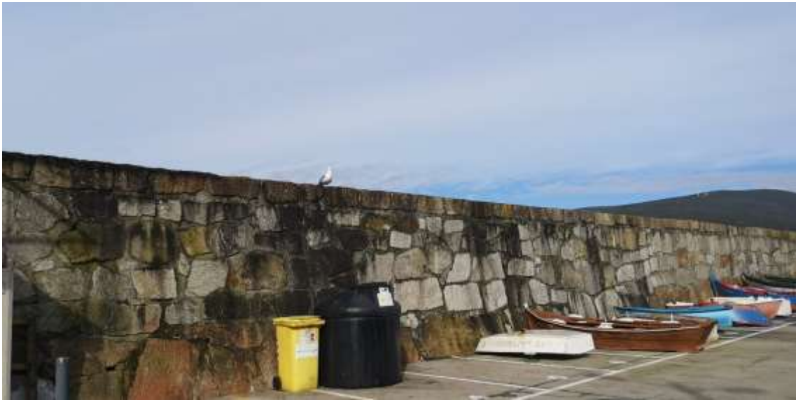
Imagen 63. Vista del espaldón del dique de abrigo y contenedores de recogida de residuos MARPOL. Fuente: ACADAR
