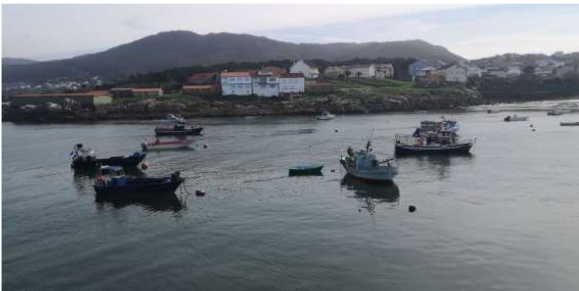
Imagen 30. Vista general de la dársena del puerto de Portocubelo. Fuente: ACADAR
