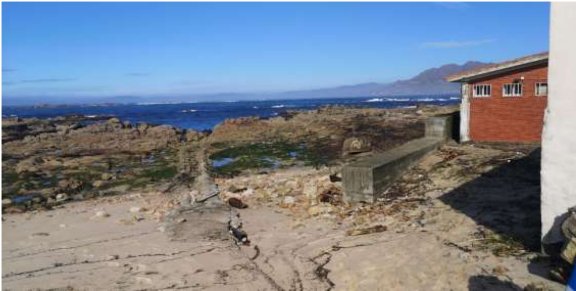
Imagen 39. Vista general de la zona sur del puerto. Fuente: ACADAR
