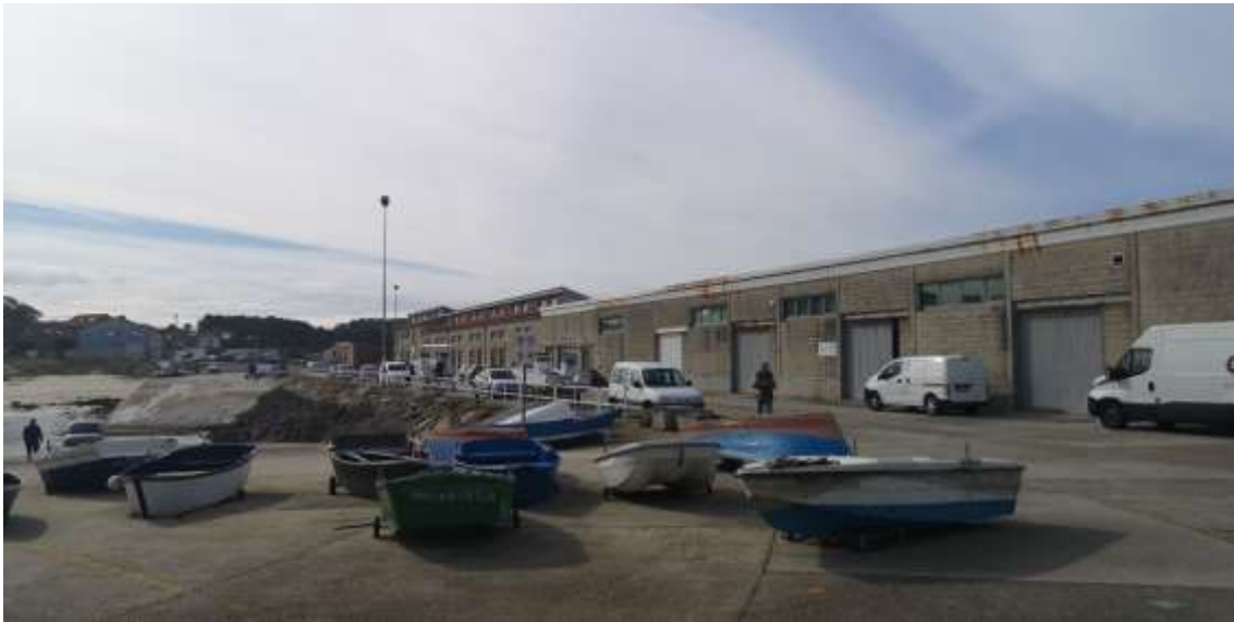
Imagen 17. Vista general de las Naves de servicios de la Cofradía de Lira, almacén y departamentos. Fuente: ACADAR
