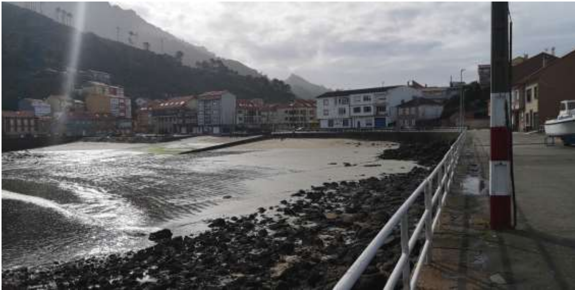
Imagen 73. Zona de acceso al puerto de O Pindo. Fuente: ACADAR
