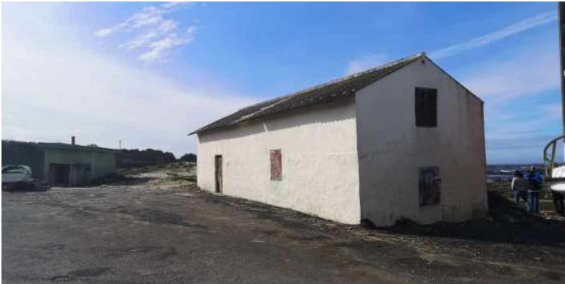
Imagen 35. Edificación antigua ubicada al lado de la vieja lonja de Lira. Fuente: ACADAR
