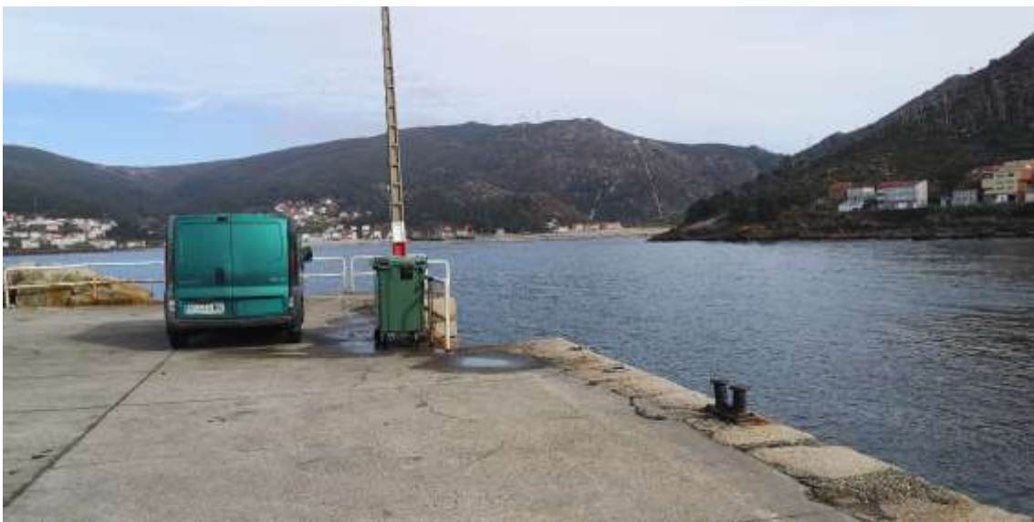
Imagen 68. Parte final del muelle y escaleras de descarga. Fuente: ACADAR
