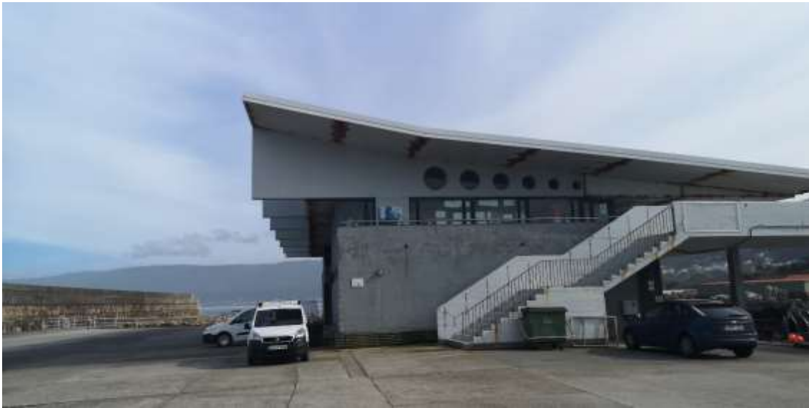
Imagen 23. Estado actual de la lonja de Lira (Portocubelo). Fuente: ACADAR
