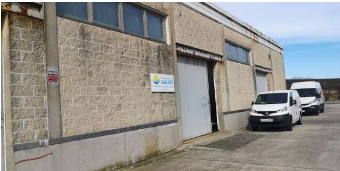
Imagen 16. Naves de servicios de la Cofradía de Lira en el puerto de Portocubelo. Fuente: ACADAR
