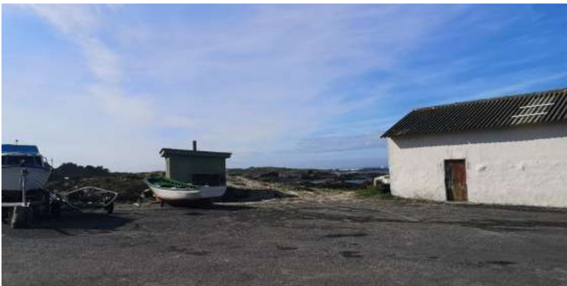
Imagen 36. Caseta de bombeo concesionada situada en la zona sur del puerto. Fuente: ACADAR.
