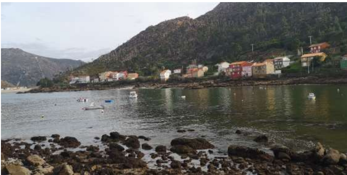
Imagen 58. Vista general de la dársena del puerto de O Pindo. Fuente: ACADAR
