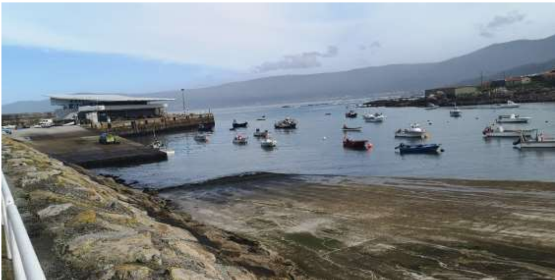
Imagen 18. Rampas de varada y dársena del puerto de Portocubelo. Fuente: ACADAR
