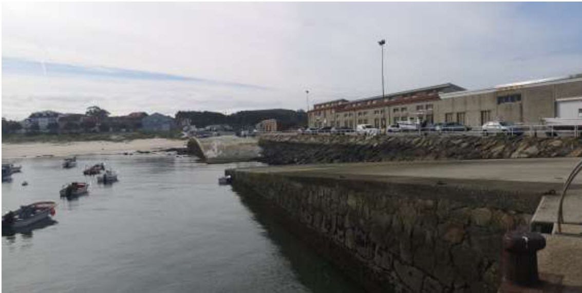
Imagen 31. Vista general de las rampas del puerto. Fuente: ACADAR
