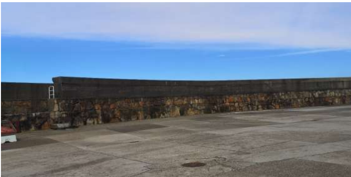
Imagen 22. Detalle del espaldón del dique de abrigo. Fuente: ACADAR
