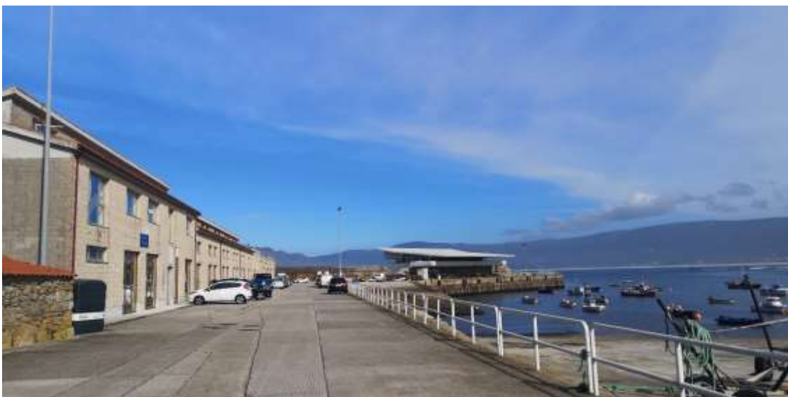
Imagen 6. Estado general del puerto de Portocubelo. Fuente: ACADAR
