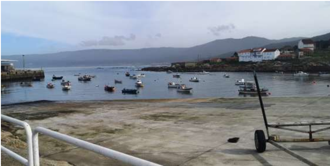
Imagen 11. Rampa sur de varada del puerto de Portocubelo. Fuente: ACADAR
