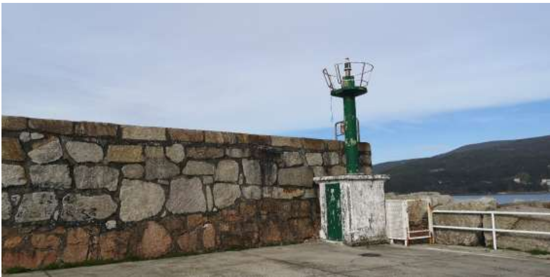
Imagen 70. Baliza verde dispuesta en el morro del dique de abrigo. Fuente: ACADAR
