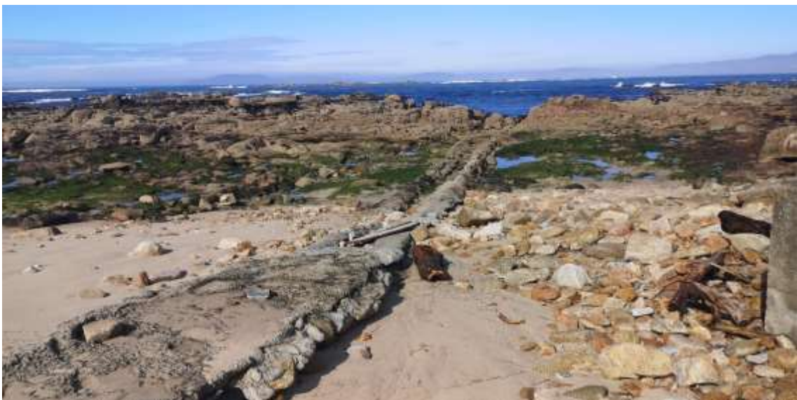
Imagen 38. Vista general de los emisarios que parten de la caseta de bombeo con dirección noroeste. Fuente: ACADAR
