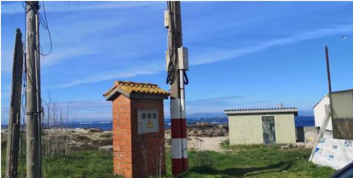
Imagen 45. Poste de luz y caseta de bombeo. Fuente: ACADAR
