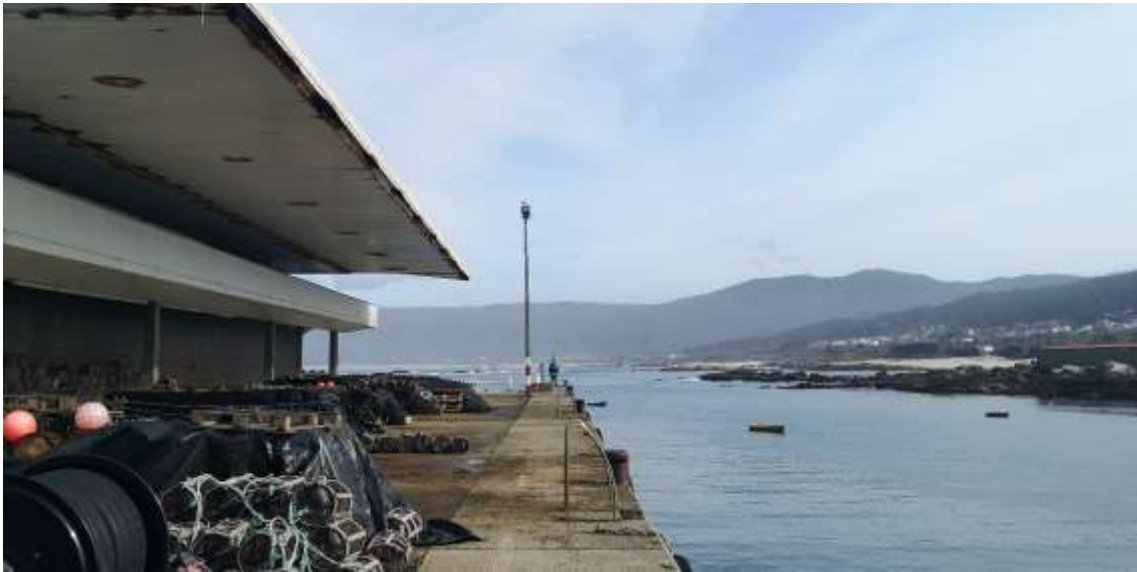
Imagen 29. Muelle principal para descargas a pie de lonja. Fuente: ACADAR
