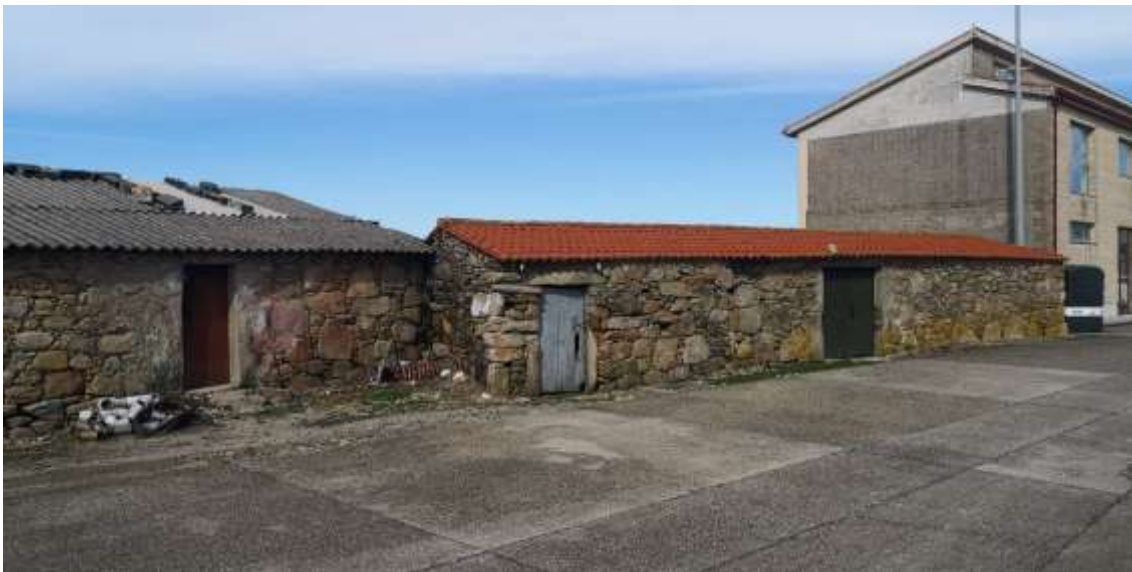
Imagen 9. Detalles de las edificaciones antiguas situadas en el puerto de Portocubelo. Fuente: ACADAR
