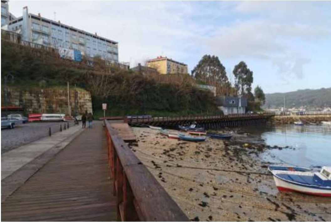
Imagen 25. Zona de acceso a la explanada de acceso a los pantalanos y edificio de la Cofradía de pescadores. Fuente: ACADAR.
