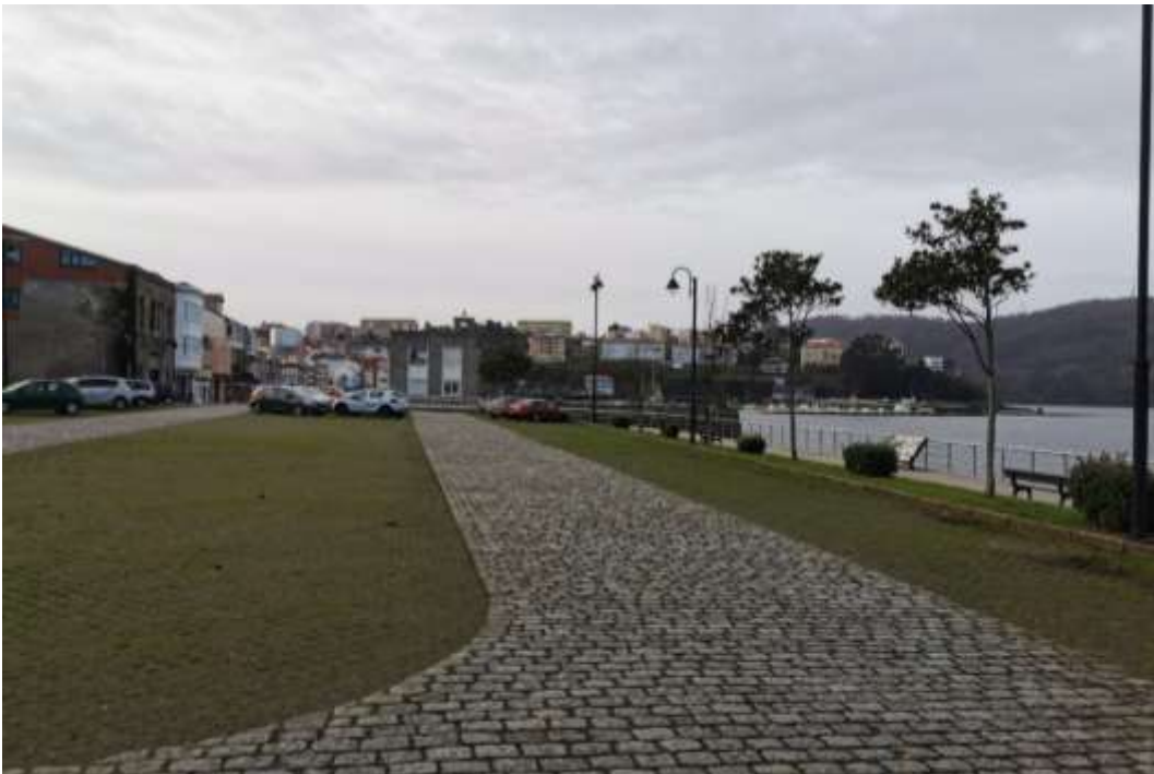
Imagen 6. Estado actual de la zona del aparcamiento construido al lado de la Casa del reloj. Fuente: ACADAR
