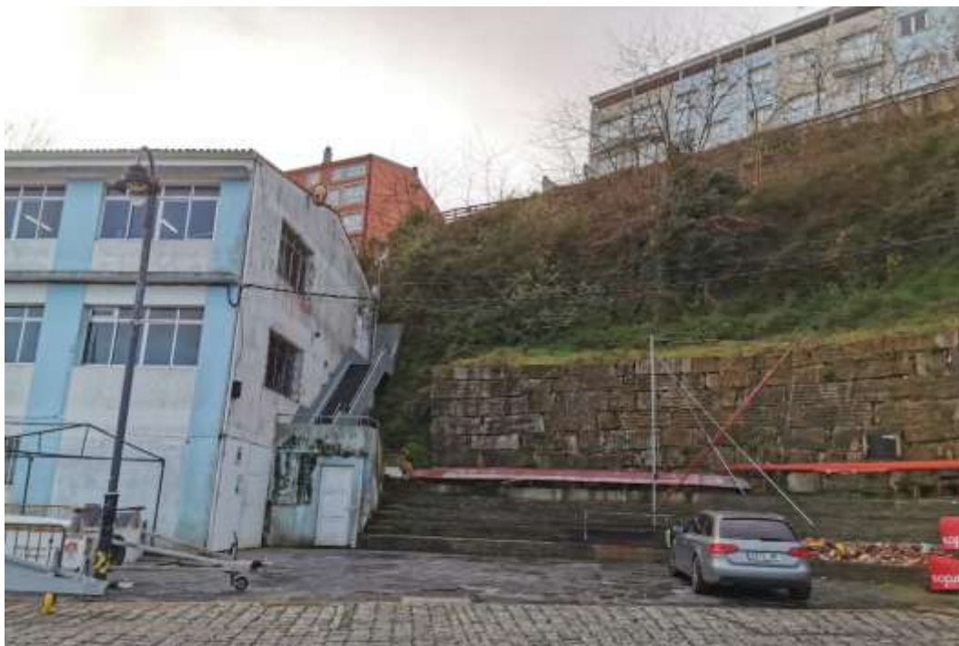
Imagen 27. Escaleras y gradas del Club de Mar que se propone desafectar en el presente documento por falta de interés portuario. Fuente: ACADAR
