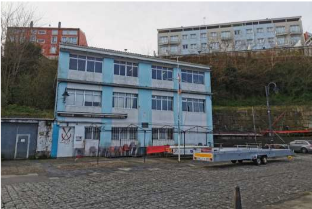
Imagen 26. Instalaciones del Club de Mar de Mugardos. Fuente: ACADAR
