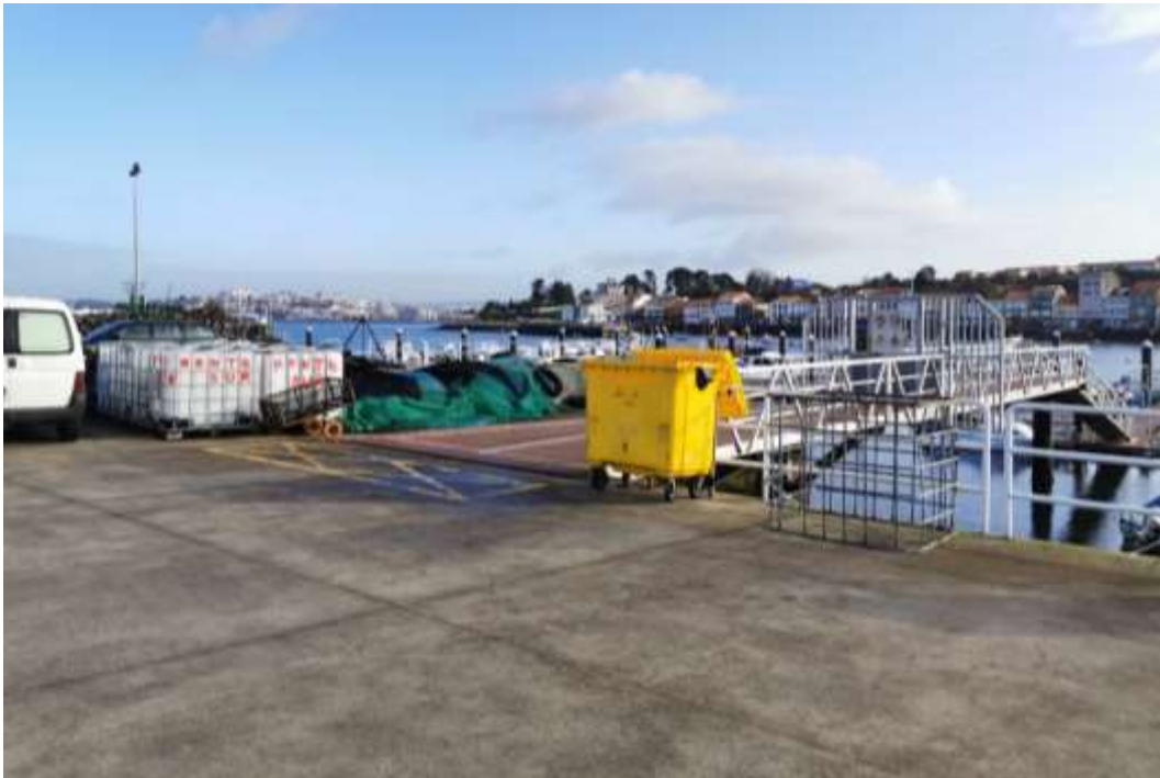
Imagen 35. Detalle de la pasarela pilotada de acceso a los pantalanes del puerto. Fuente: ACADAR
