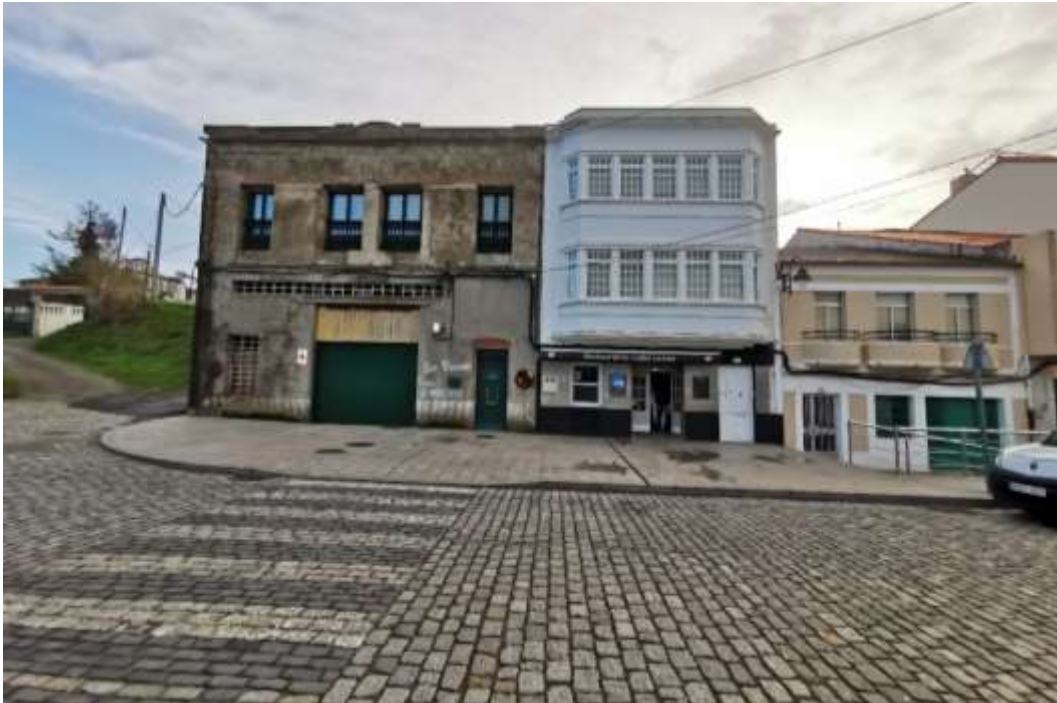
Imagen 12. Edificaciones ubicadas frente a la Casa del reloj y tramo de acera (terrazas) incluido dentro de la zona de servicio del puerto. Fuente: ACADAR
