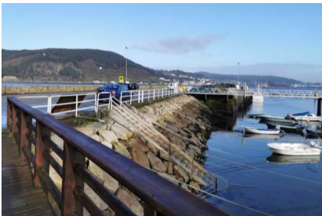
Imagen 33. Relleno y explanada que constituyen la zona sur del puerto de Mugaros. Fuente: ACADAR
