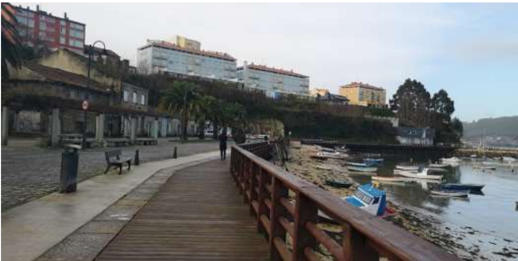
Imagen 24. Vial principal y paseo peatonal que une las dos zonas del puerto. Fuente: ACADAR
