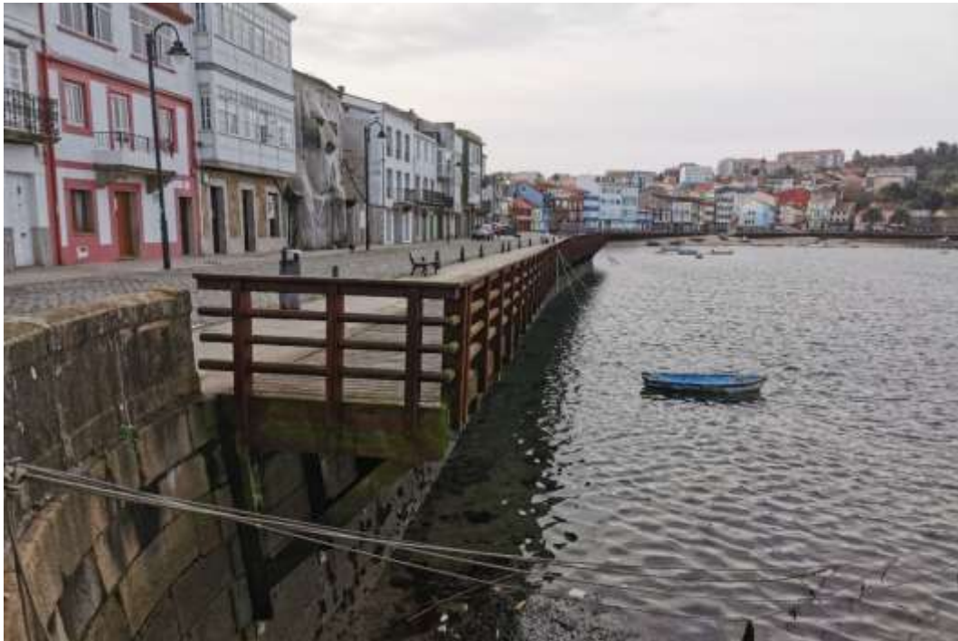
Imagen 17. Paseo de madera y vial que une los dos extremos del puerto de Mugardos. Fuente: ACADAR
