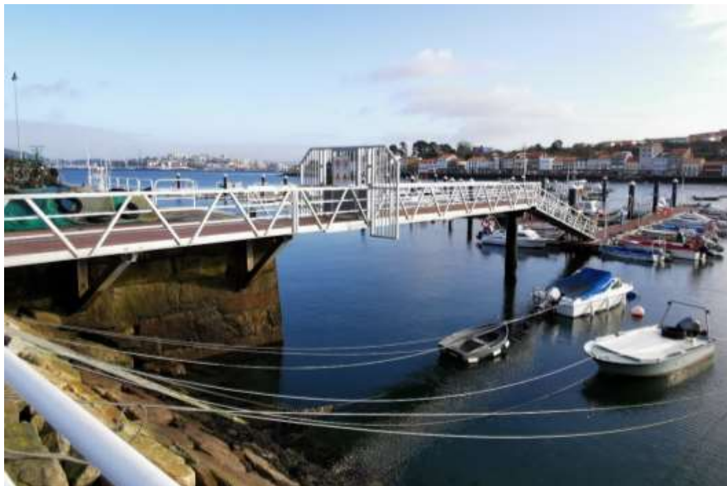
Imagen 38. Detalle de la pasarela de acceso a los pantalanes del puerto. Fuente: ACADAR
