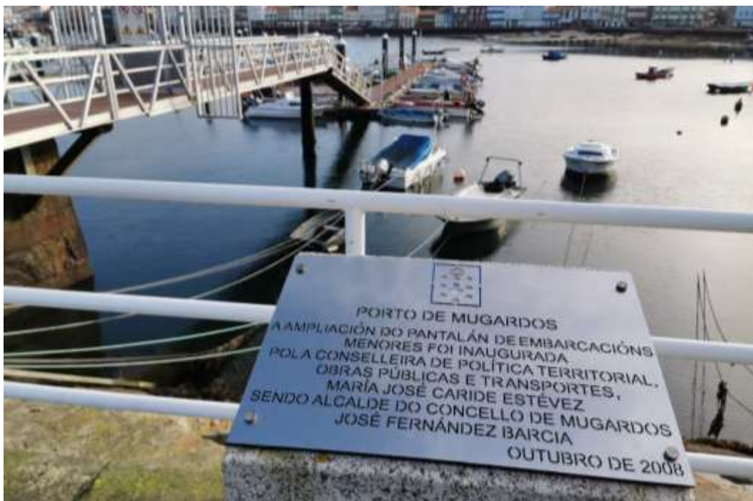
Imagen 40. Placa conmemorativa de la ampliación llevada a cabo en la zona sur del puerto de Mugardos inaugurada en 2008. Fuente: ACADAR
