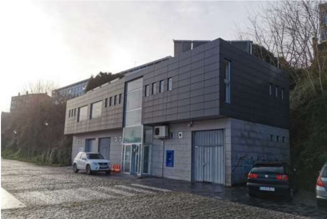
Imagen 29. Edificio multiservicios en la zona suroeste del puerto de Mugaros. Fuente: ACADAR
