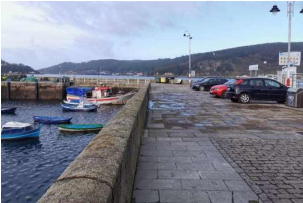
Imagen 15. Muelle pesquero norte del puerto de Mugardos. Fuente: ACADAR
