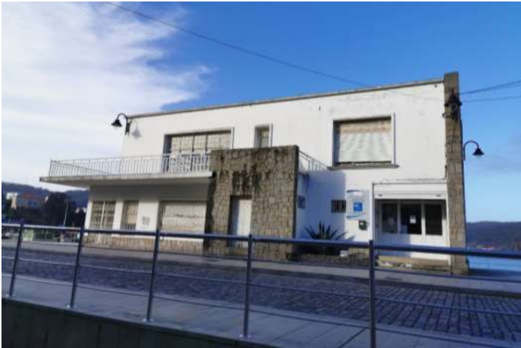
Imagen 11. Vista de la fachada principal de la Casa del reloj del puerto de Mugardos. Fuente: ACADAR
