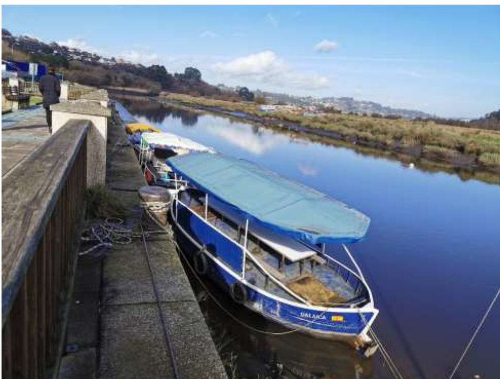
Imagen 12. Cantil del muelle con embarcaciones atracadas. Fuente: ACADAR
