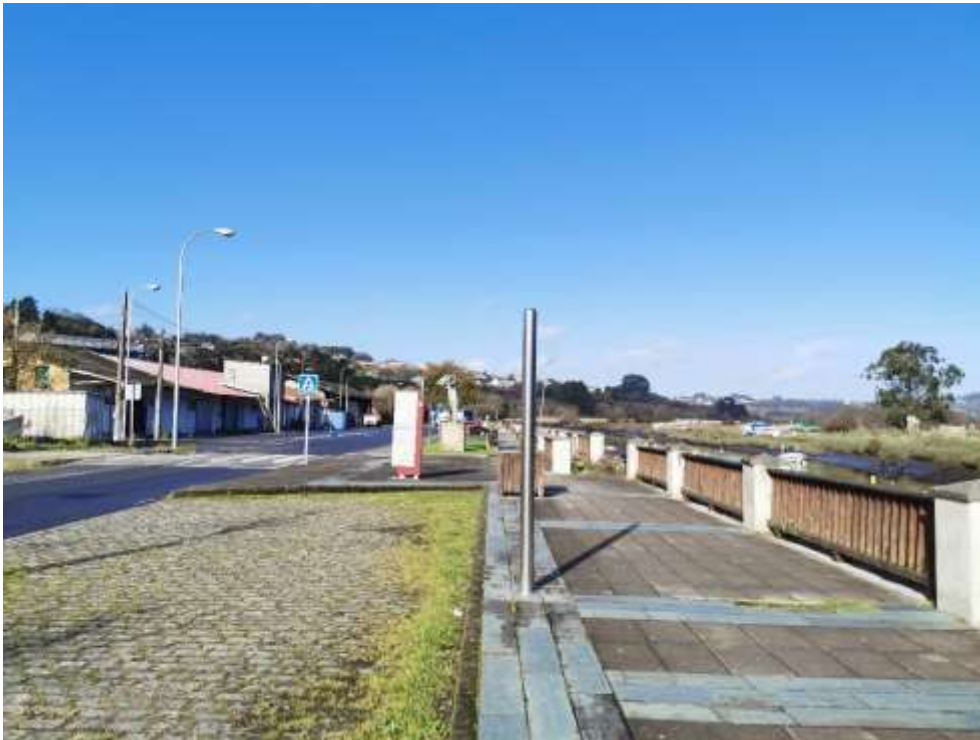
Imagen 7. Muelle principal, zona de aparcamiento y vial principal del puerto. Fuente: ACADAR
