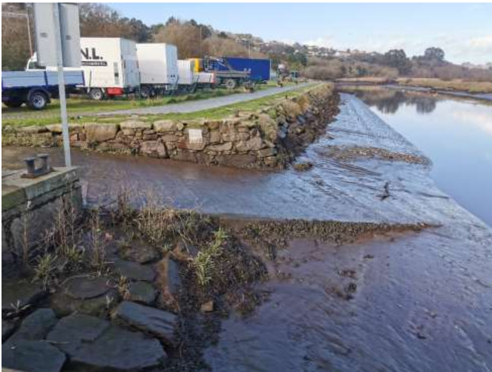
Imagen 17. Vista general del relleno propuesto para su reversión. Fuente: ACADAR
