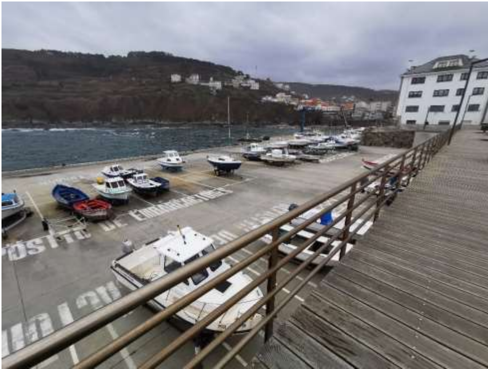
Imagen 29. Explanada donde se ubica la marina seca vista desde la pasarela superior que atraviesa la zona de servicio del puerto. Fuente: ACADAR
