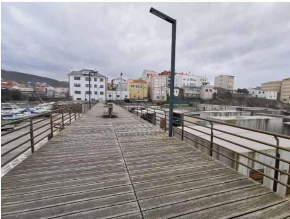
Imagen 28. Pasarela de madera que atraviesa la zona de servicio del puerto de Caión. Fuente: ACADAR
