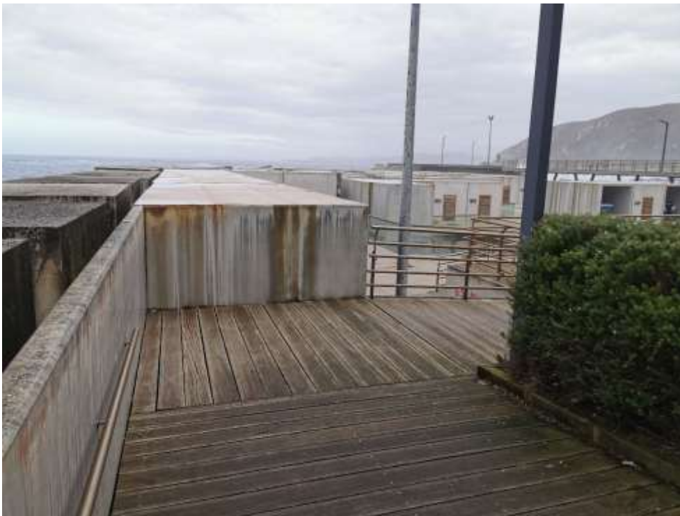
Imagen 25. Acceso a los departamentos ubicados en la ampliación del puerto de Caión. Fuente: ACADAR
