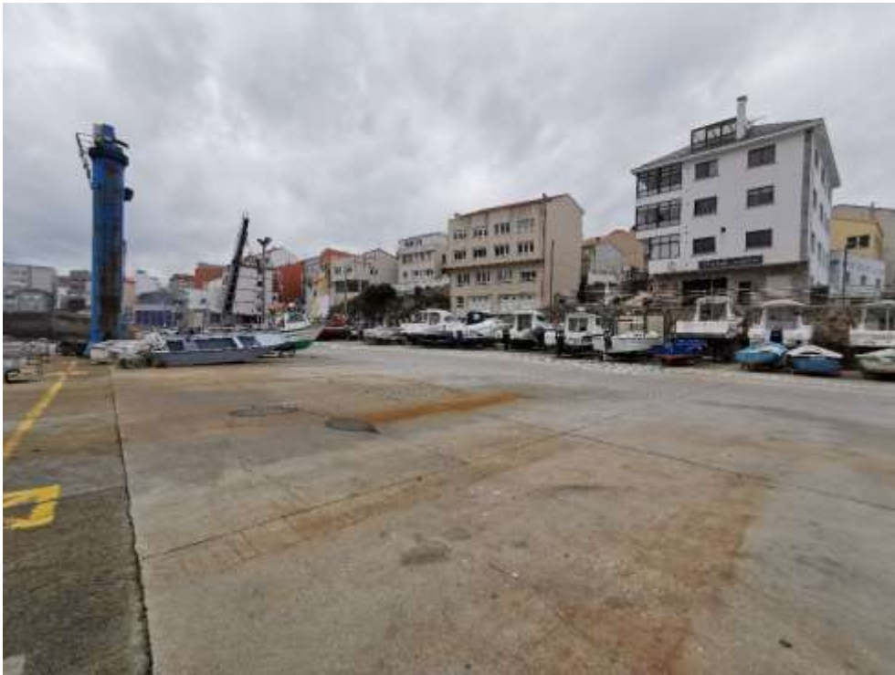
Imagen 13. Explanada de varada para embarcaciones pesqueras y náutico-deportivas. Fuente: ACADAR
