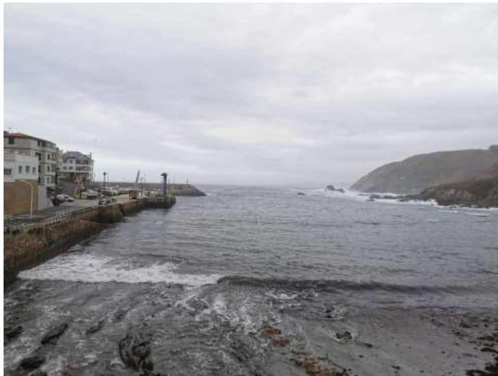
Imagen 8. Vista general del Puerto de Caión desde el vial de acceso. Fuente: ACADAR
