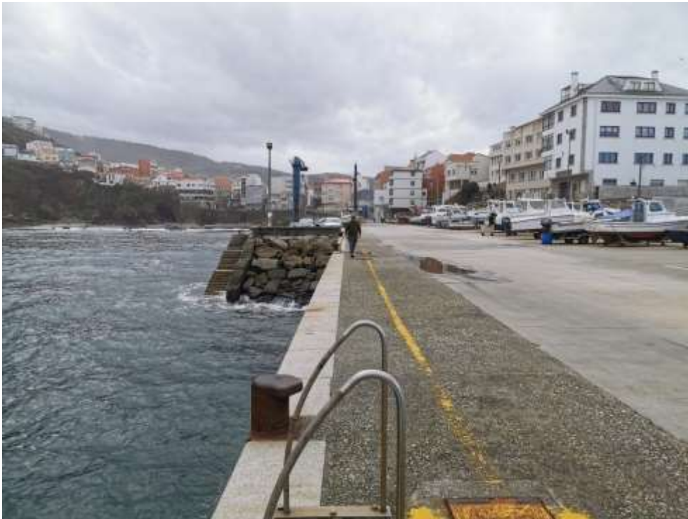
Imagen 17. Muelle de uso pesquero, explanada anexa y zona de varada al fondo. Fuente: ACADAR
