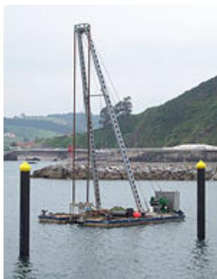
La plataforma flotante para el hincado de pilotes estará adecuada al RD 1215/97.
