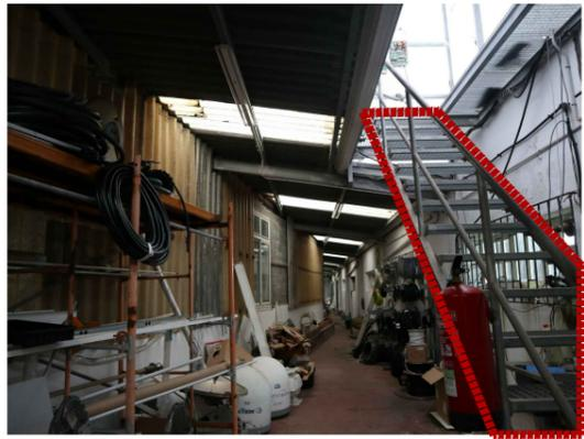
FOTOGRAFÍA A: escalera de tramex de acceso a cubierta con caseta de policarb.
