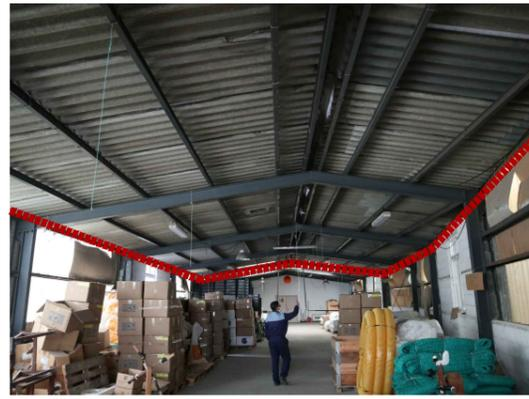
FOTOGRAFÍA B: estructura vista con cubierta de uralita y luminarias descolgadas
