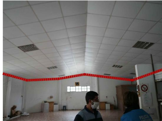
FOTOGRAFÍA B: falso techo desmontable con aislamiento y luminarias empotradas
