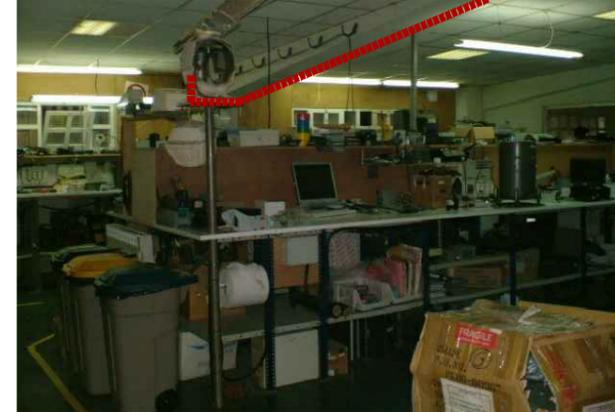
FOTOGRAFÍA C: falso techo desmontable con aislamiento y luminarias empotradas con vigas delcolg.
